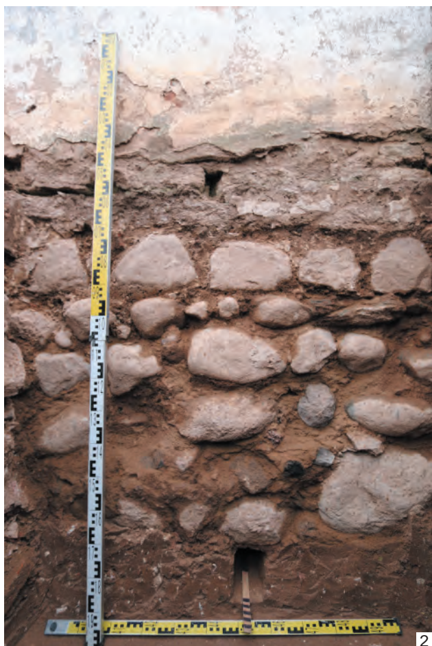
Рис. 4. 1 — церковь Николы на Липне, раскоп 14, известковая проливка в интерьере храма, вид с запада (сверху); 2 — Никольский Липенский монастырь, 2016 г., шурф 6, фундамент южной стены, вид с юга. Фотографии И. В. Антипова
