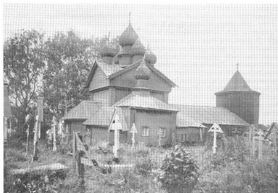
Рис. 3. Троицкая церковь в с. Помялово
