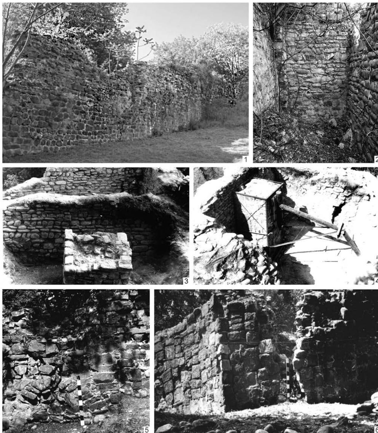
Рис. 3. Крепость Годлик: 1 — фрагмент северной части восточной стены со стыковкой южной стены башни III, вид с юго-востока после расчистки; 2 — башня III, южная часть, «каменный мешок», вид с востока, сверху; 3 — башня III, северная часть башни в процессе вскрытия, столб возле поперечной стены до реставрации, вид с севера; 4 — башня III, северная часть башни после расчистки, столб возле поперечной стены после реставрации (столб в каркасе), вид с северо-востока; 5 — башня III, фрагмент северной части восточной стены возле башни III с внешней стороны, арочное перекрытие въездных ворот, до расчистки; 6 — полукруглая башня VII, фасад, вид с юга
