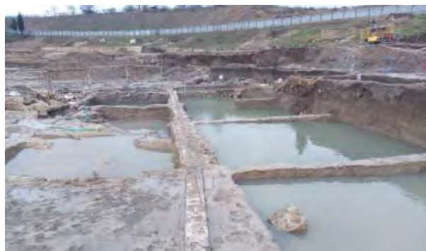
Рис. 4. ОАН «Южный пригород древнего города Херсонес Таврический». Раскоп 5. Затопление раскопа грунтовыми водами
