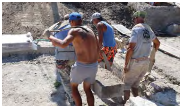
Рис. 6. Неразрушающая разборка и перенос детали объекта вручную с использованием широких строп
