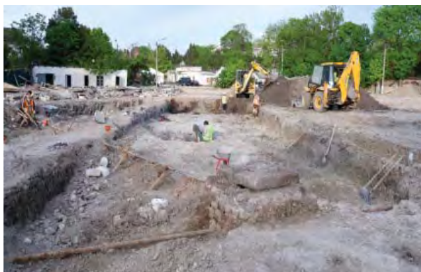
Рис. 10. ОАН «Южный пригород древнего города Херсонес Таврический». Раскоп 1. Водопровод и водоразборный коллектор. Вид с юга
