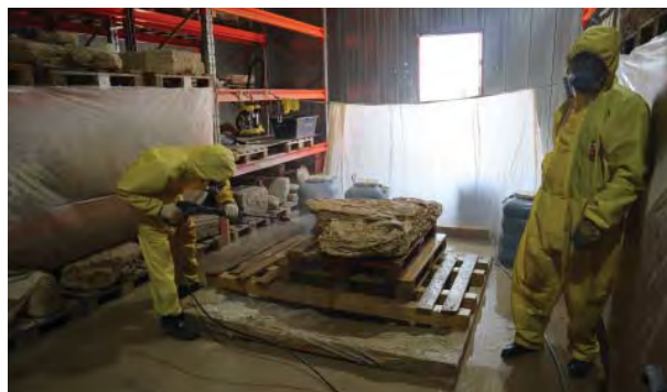
Рис. 16. Пропитывание с помощью пульверизатора детали камня укрепляющим раствором на основе гидравлической извести
