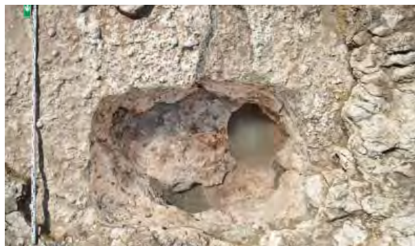
Рис. 7. ОАН «Южный пригород древнего города Херсонес Таврический». Раскоп 7. Водосборная цистерна (объект 226). Вид с севера
