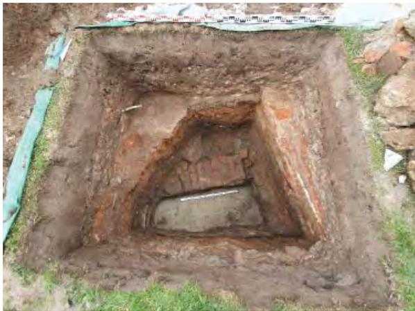
Рис. 3. Домик Петра. 2022 г. Шурф 1. Кирпичная кладка и бутовый фундамент. Вид с юга
