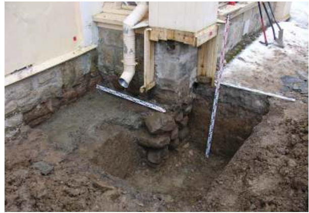
Рис. 4. Извара-2017. Фундамент веранды и глиняный замок усадебного дома в шурфе. Вид с северо-востока
