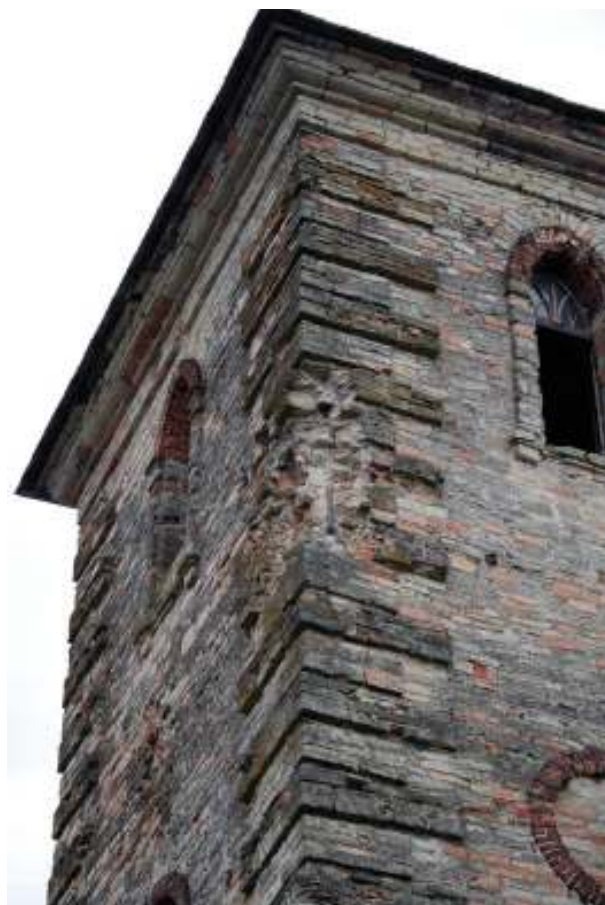
Рис. 7. «Kukkonkirkko» – «Петушиная церковь». Утраты кладки между вторым и третьим ярусами кирпичи. Фото В. Ю. Соболева
