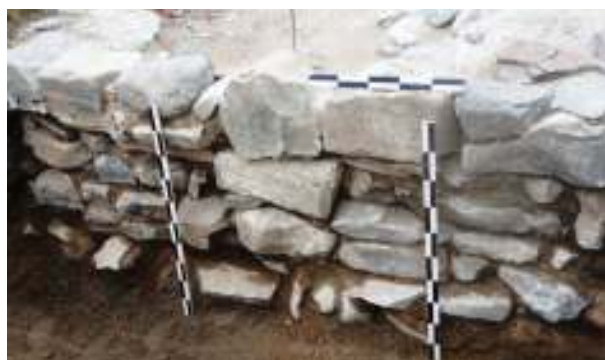
Рис. 4. Церковь Воскресения Господня. 2017. Фундаментная кладка западной стены
