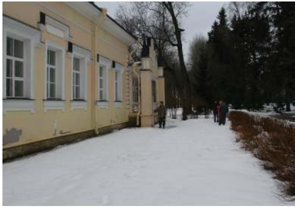
Рис. 3. Извара-2017. Место закладки шурфа у северо-восточного угла веранды усадебного дома. Вид с северо-северо-востока
