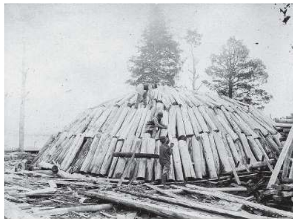
Рис. 16. Укладка угольной кучи. Олонецкий уезд. 1899 г. Фото М. А. Круковского (МАЭ. Колл. № 1363)
