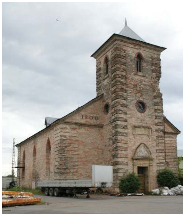
Рис. 4. «Kukkonkirkko» – «Петушиная церковь». Портал и северный фасад. Вид с северо-запада. Фото В. Ю. Соболева
