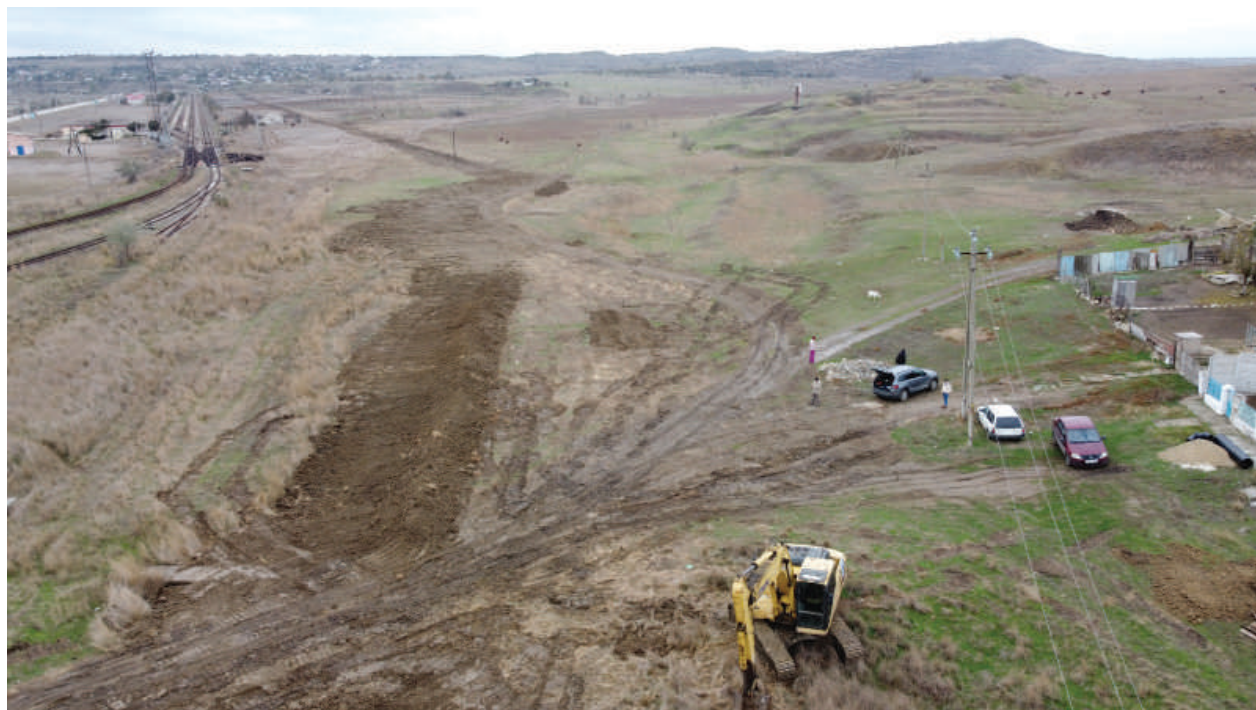
Рис. 3. ОАН «Городище Порфмий». Засыпанная траншея с трубами водовода. Вид с севера
