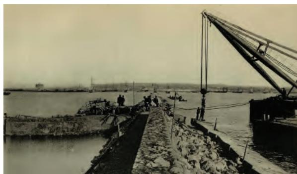
Рис. 10. Строительство Защитного мола
