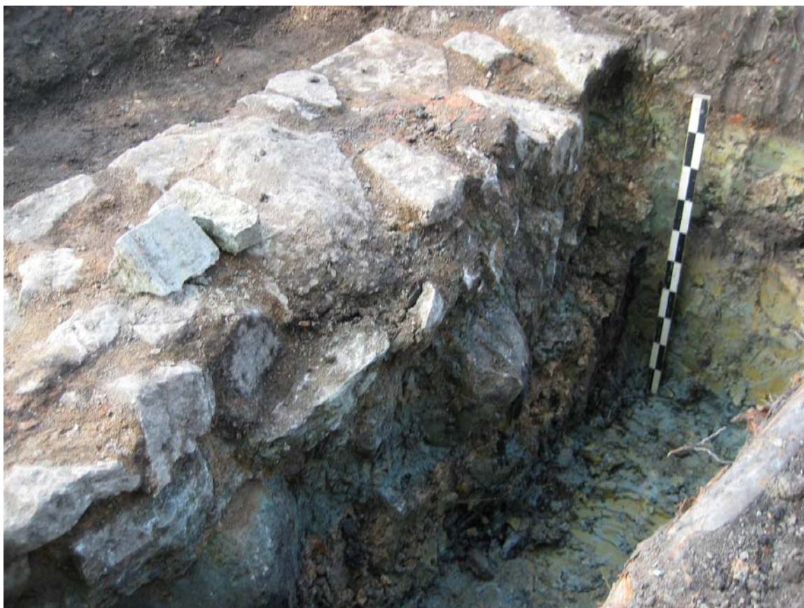
Рис. 14. Фрагмент раскрытой части фундамента восточной ограды Телеграфного садика. Вид с юго-востока
