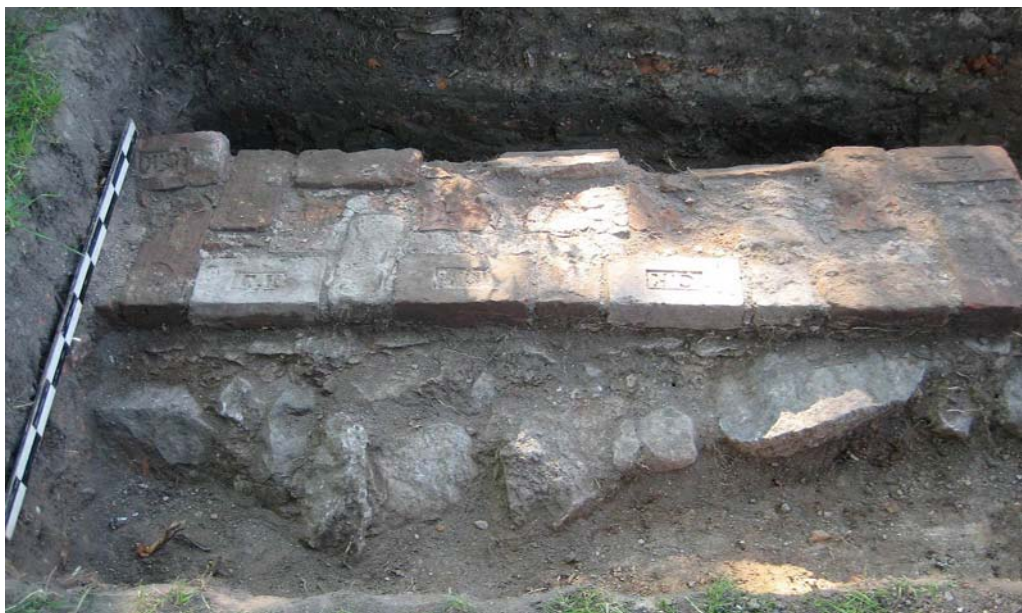
Рис. 13. Остатки кирпичной кладки верхней части фундамента восточной ограды Телеграфного сада. Вид с востока
