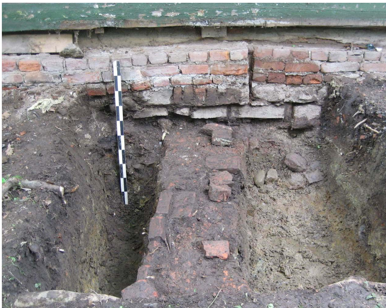
Рис. 4. Примыкание кирпичной подпорной конструкции западной стенки кладовой к фундаменту северной стены Фельдъегерского дома. Вид с севера
