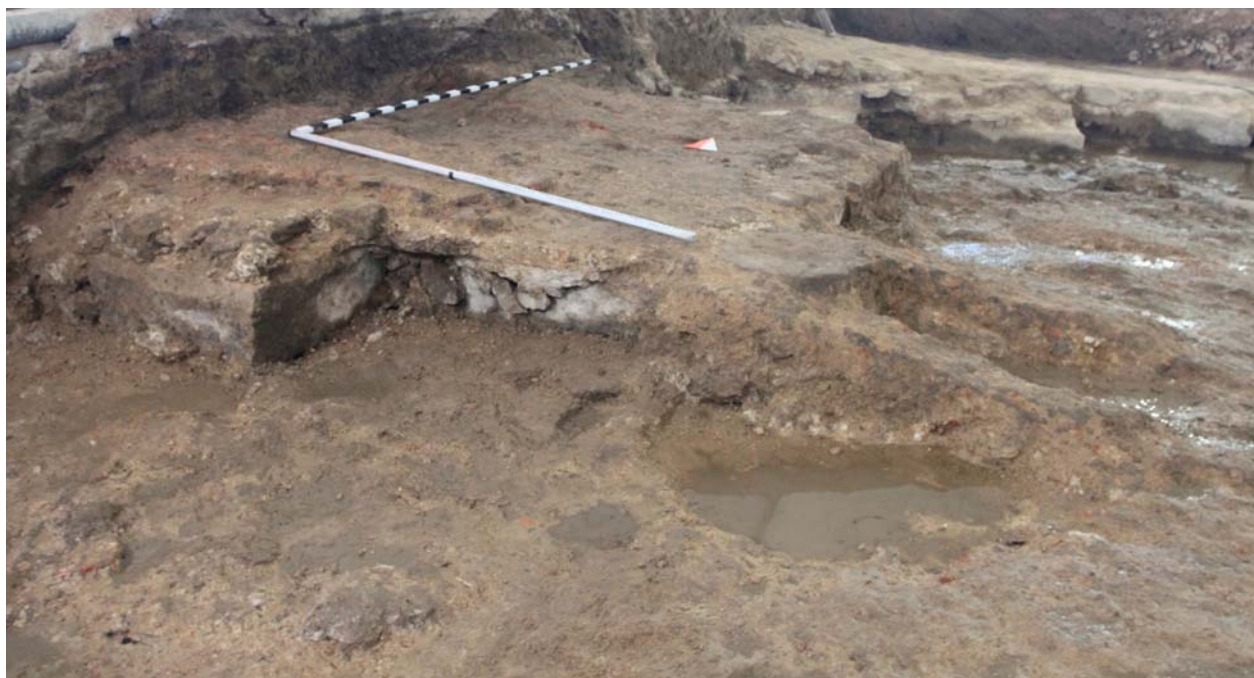
Рис. 10. Фрагменты юго-западной части фундамента колокольни. Вид с юго-востока
