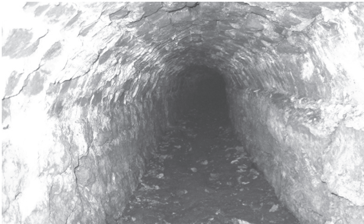
Рис. 19. Шурфы I–IV: внутренняя часть коллектора ливневой канализации 1811 г. Вид с юга
