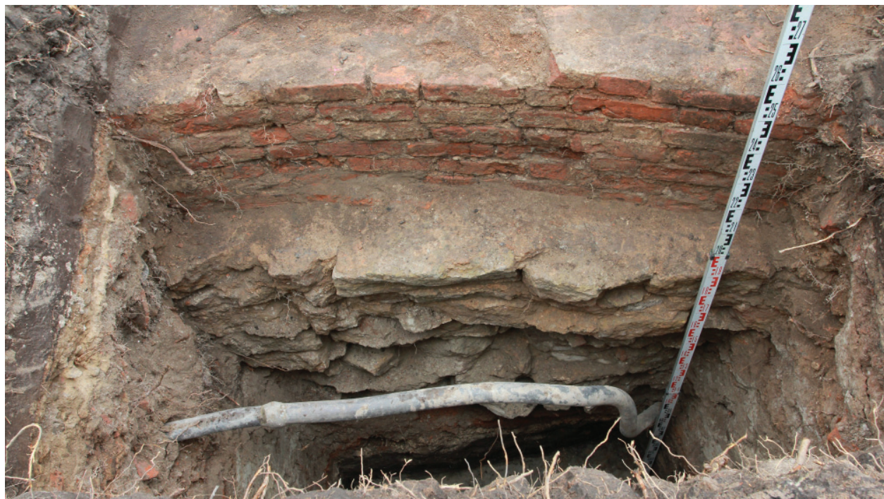
Рис. 24. Набережная р. Мойки, д. 102. Шурф 3. Фундамент и часть стены башни. Вид с востока
