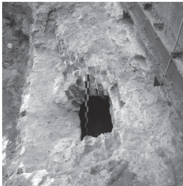
Рис. 18. Шурфы I–IV: промер остаточной глубины створа коллектора ливневой канализации. Вид с севера
