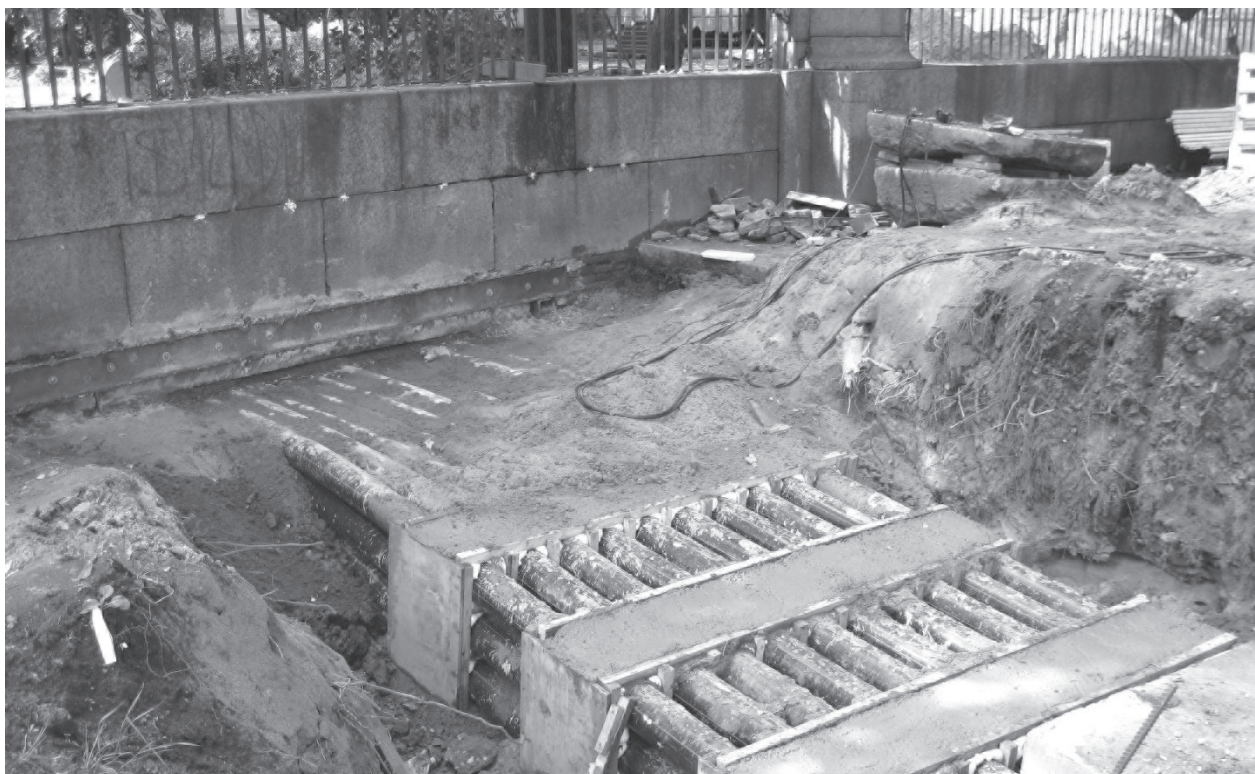
Рис. 20. Подведение под цоколь Воронихинской ограды кабельных линий электромагистрали. Вид с юго-востока
