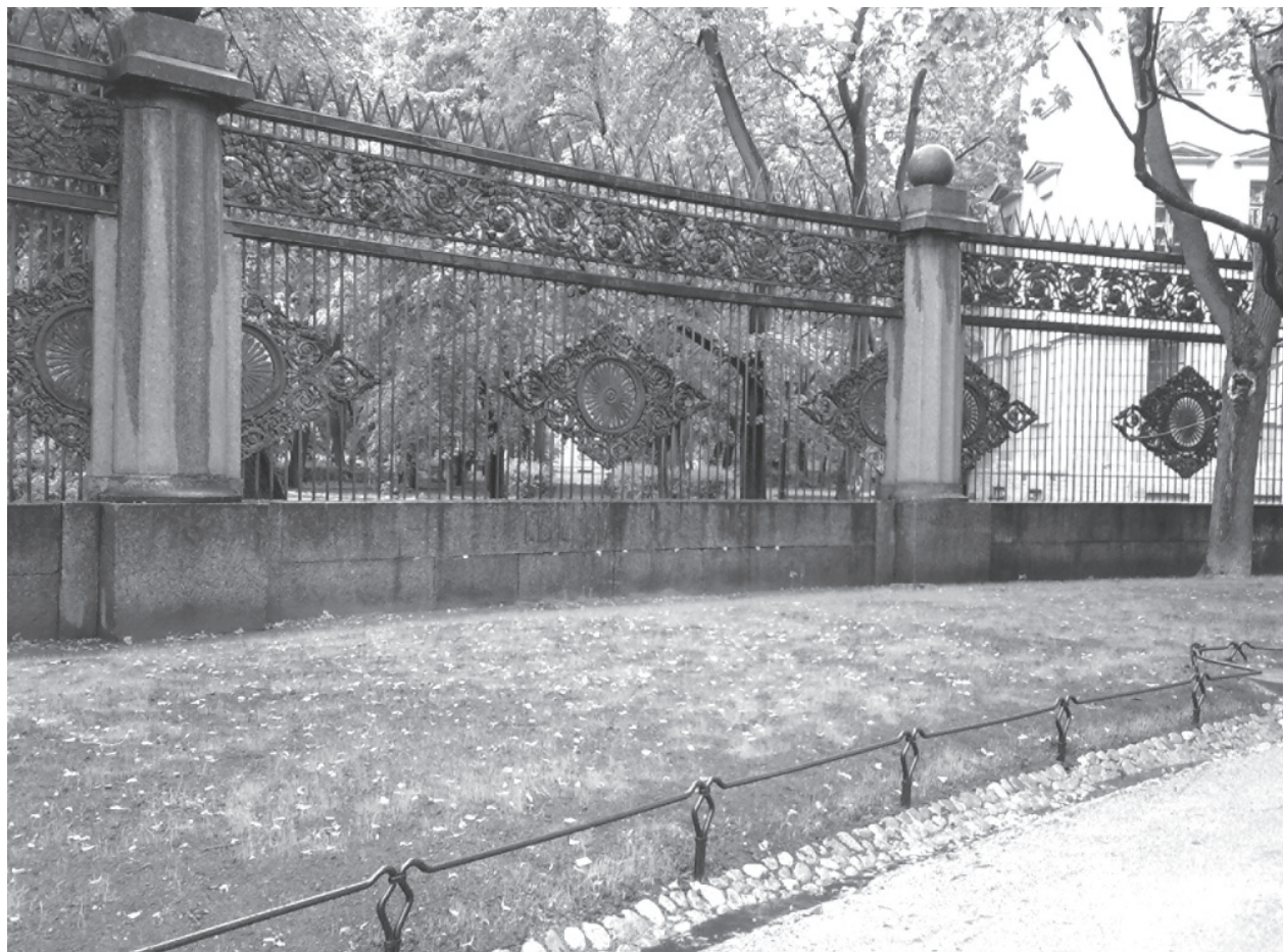
Рис. 3. Центральная часть Воронихинской ограды (1811–1812 гг.) на Казанской улице. Современное фото. Вид с юго-востока
