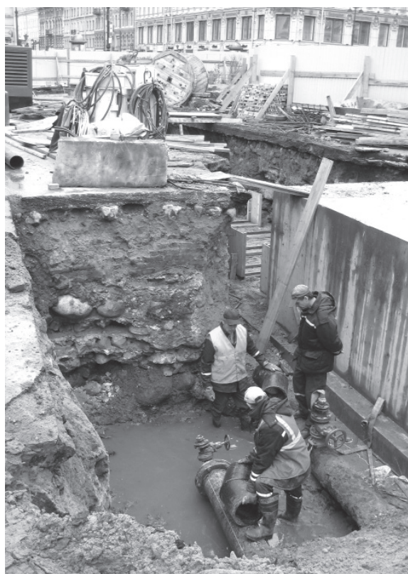
Рис. 8. Строительная траншея на Казанской улице в слое XVIII в. Вид с юга
