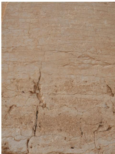
*Рис. 16. Развитие вертикальных трещин, соединяющих горизонтальные стилолитовые швы*
