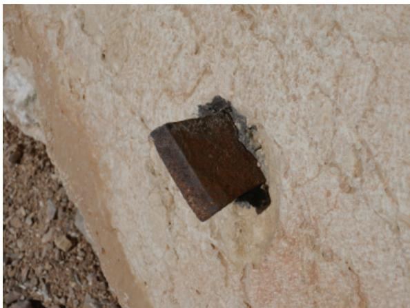
*Рис. 12. Металлический «шип», зафиксированный свинцом*
