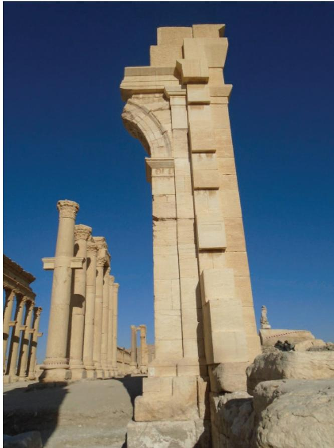
*Рис. 8. Сохранение пилона, восстановленного при реставрации Р. Ами*
