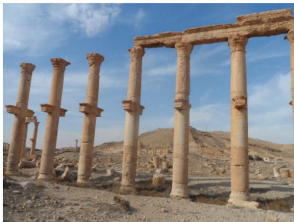
*Рис. 17. Выветривание верхних частей архитектурных построек*
