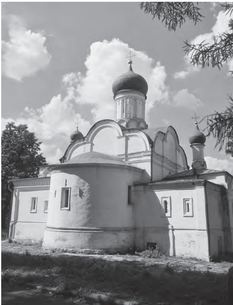
Ил. 2. Москва. Церковь Зачатия Анны, что в углу Китайгородской стены. Вид с северо-востока. Фото А.М. Салимова. 2014 г.
