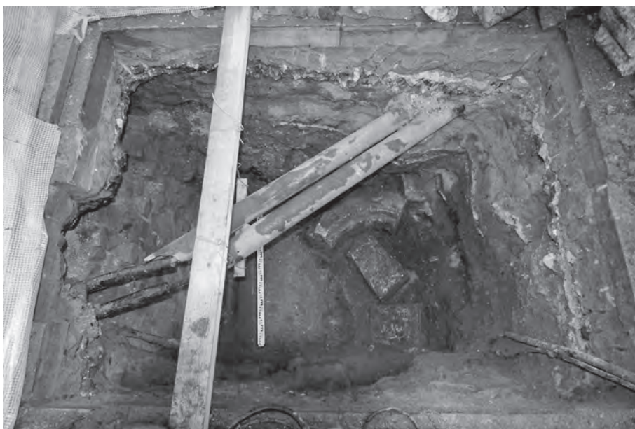
Ил. 4. Москва, Московский Кремль, Грановитая палата. Шурф № 1. Расчистка завала архитектурных деталей в подсыпке под конструкцией Соборной площади. Вид с востока
