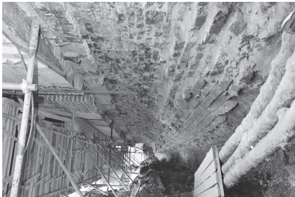
Ил. 19. Москва, Московский Кремль, Грановитая палата. Граншея вдоль северного фасада здания. Общий вид с запада (видно состояние кирпичного цоколя северного фасада и его ремонты XVII в.)
