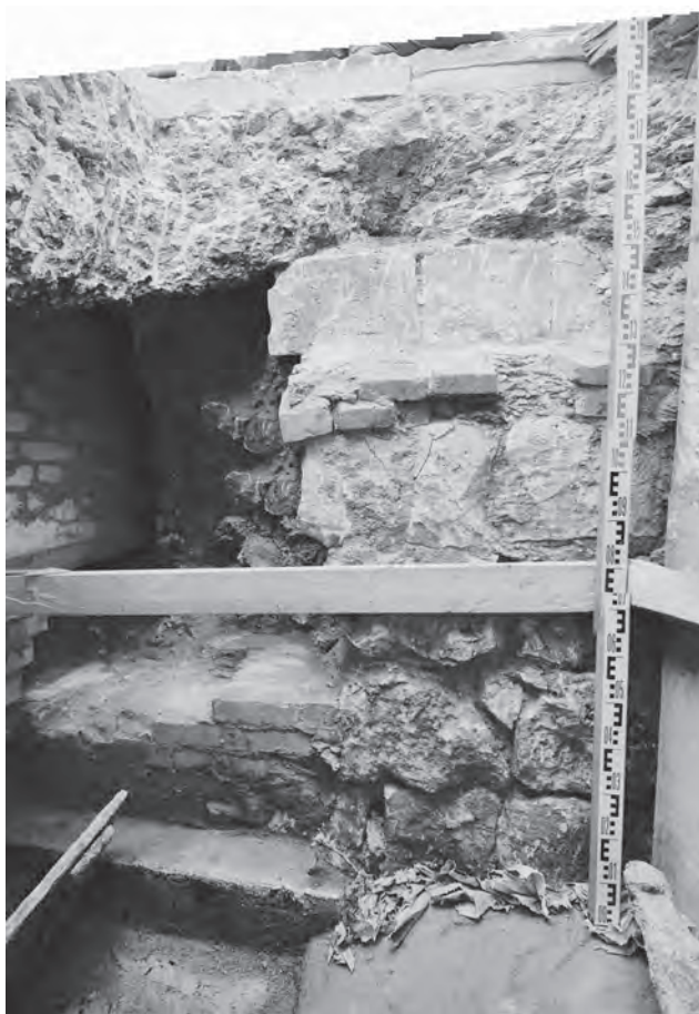
Ил. 12. Москва, Московский Кремль, Грановитая палата. Шурф № 3. Западная стенка шурфа, общий вид (зафиксированы нижний ряд белокаменного цоколя восточного фасада палаты и четыре ряда каменной кладки фундамента)
