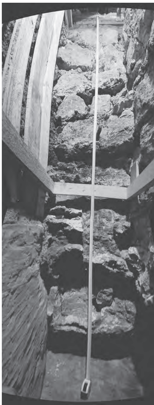
Ил. 14. Москва, Московский Кремль, Грановитая палата. Шурф № 4. Панорамный вид южной стенки шурфа и фундамента южной стены палаты
