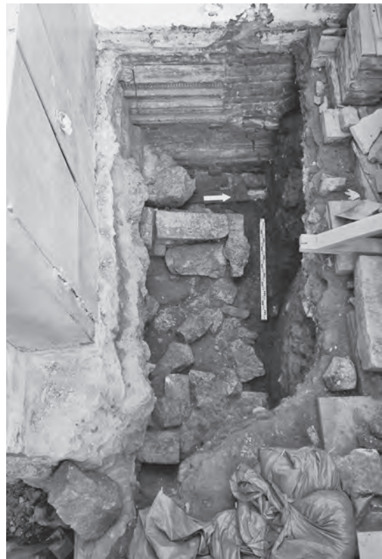
Ил. 27. Москва, Московский Кремль, Грановитая палата. Траншея вдоль северного фасада здания. Участок возле арки XVII в. и восточного фасада северного корпуса Теремного дворца. Общий вид сверху с востока, после раскрытия фундамента арки
