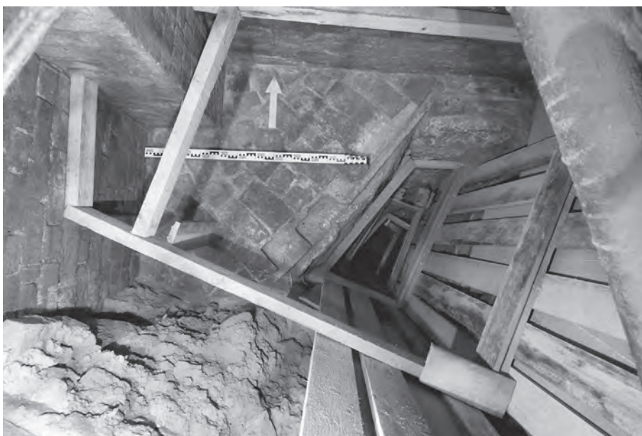
Ил. 9. Москва, Московский Кремль, Грановитая палата. Шурф № 2. Вид перед началом работ сверху с юга. Платформа опорного пилона центрального столба парадного яруса Грановитой палаты
