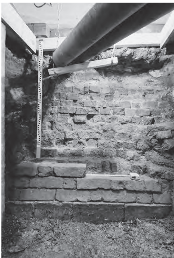
Ил. 5. Москва, Московский Кремль, Грановитая палата. Шурф № 1. Южная стенка шурфа (видны остатки наклонного кирпичного цоколя и белокаменные блоки его основания). Вид с севера
