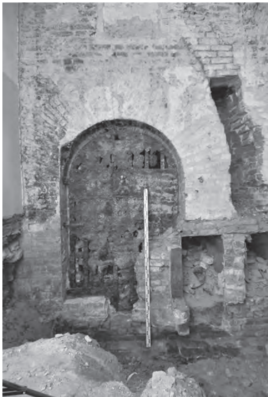
Ил. 26. Москва, Московский Кремль, Грановитая палата. Дверной проём в западной стене юго-западного помещения подклета, сохранившееся в закладке дверное полотно, XV-XVII вв. Вид с востока
