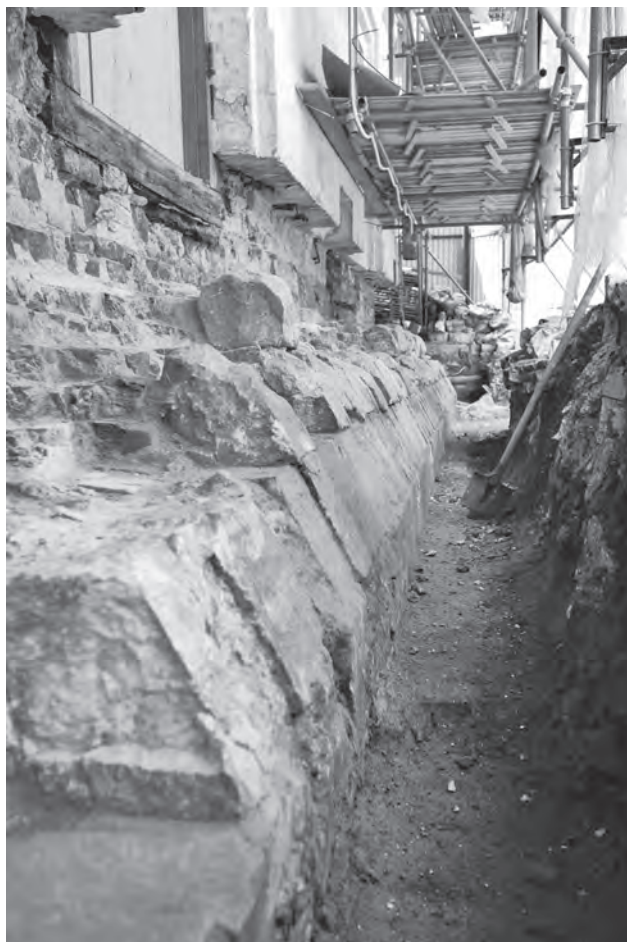
Ил. 17. Москва, Московский Кремль, Грановитая палата. Восточный фасад палаты. Белокаменный цоколь, сохранившийся под восточным крыльцом. Вид в процессе расчистки с юга из траншеи
