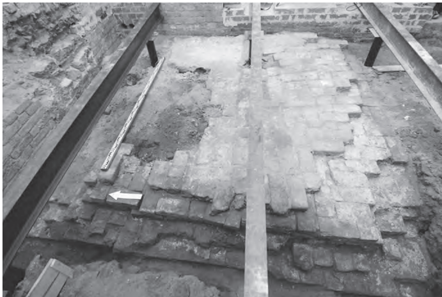
Ил. 25. Москва, Московский Кремль, Грановитая палата. Кирпичная платформа неизвестного назначения в северо-восточном углу северо-западного помещения подклета. Вид с запада
