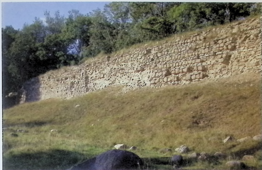
Гдовская крепость. Участок юго-западной стены.
