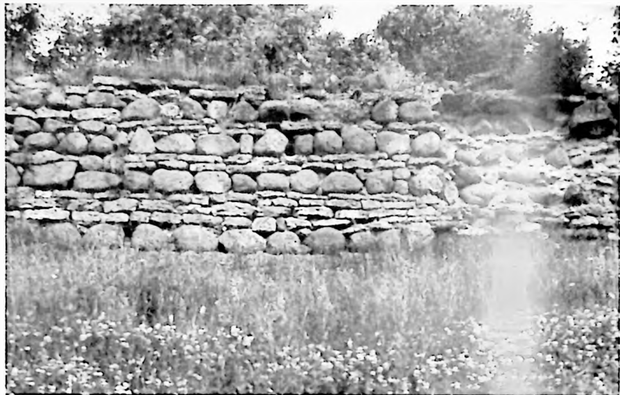
Участок юго-восточной стены.
