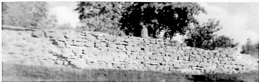
Участок юго-восточной стены.
