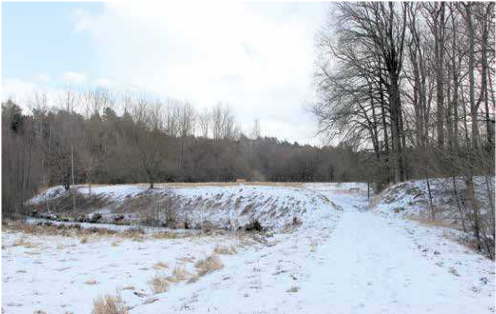
Рис. 2. «Древнее городище» Холленштедт. Большая часть вала сегодня реконструирована. Вид с запада
