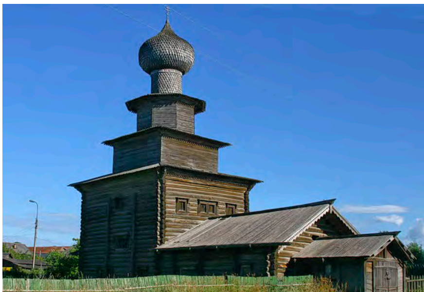
Рис. 1. Церковь Ильи Пророка. г. Белозерск. 1696 г. Фото до реставрации.
