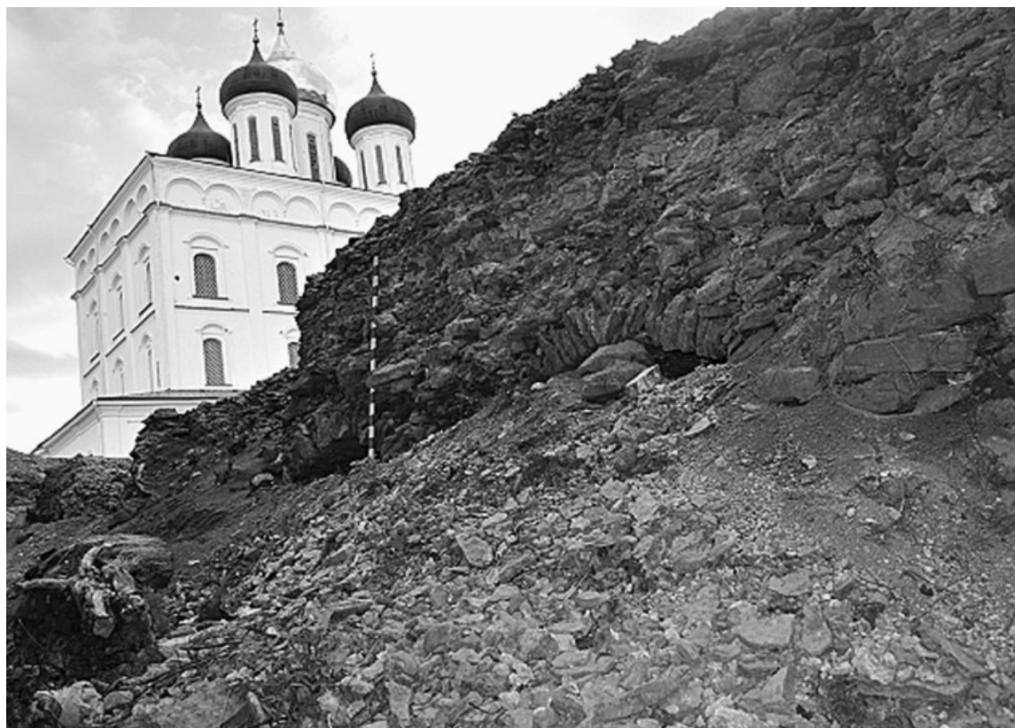
Рис. 16. Сводчатое перекрытие проёма в обрушивающейся западной стене Владычных палат. Вид с запада
