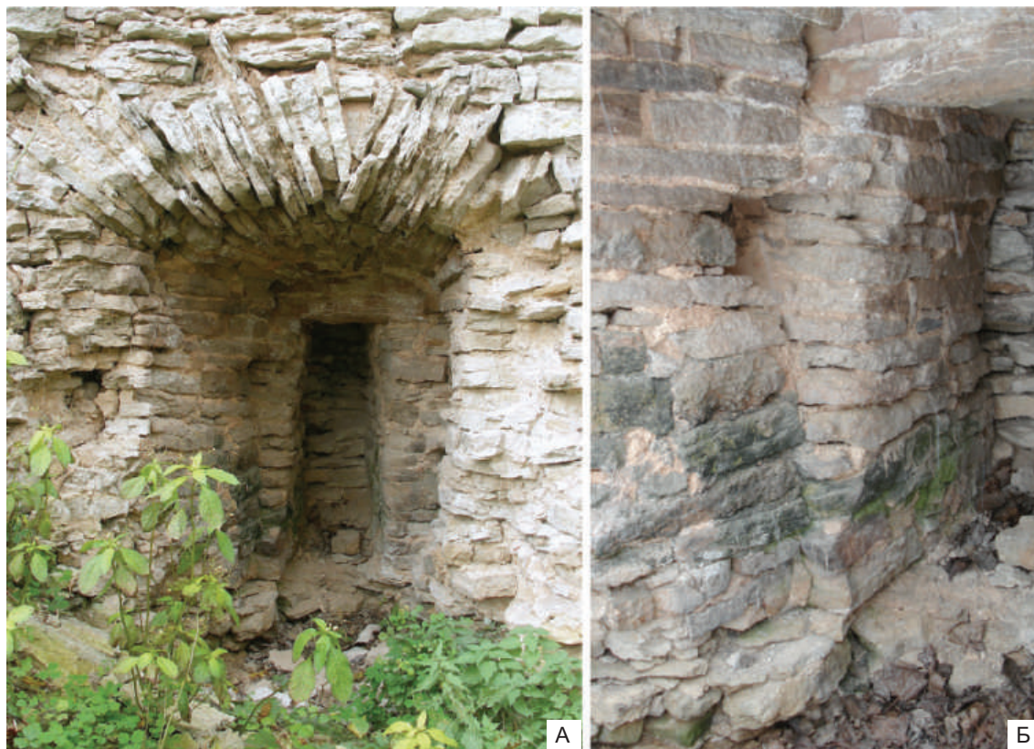
Рис. 4. Бойница в западной стене: А — общий вид.; Б — южный откос с гнездом от запорного бруса
