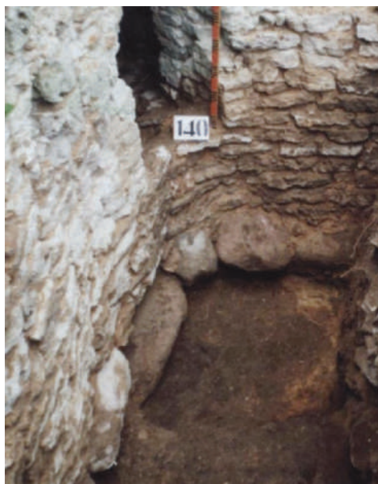
Рис. 10. Основание северо-западного угла крепости, вид с юга
