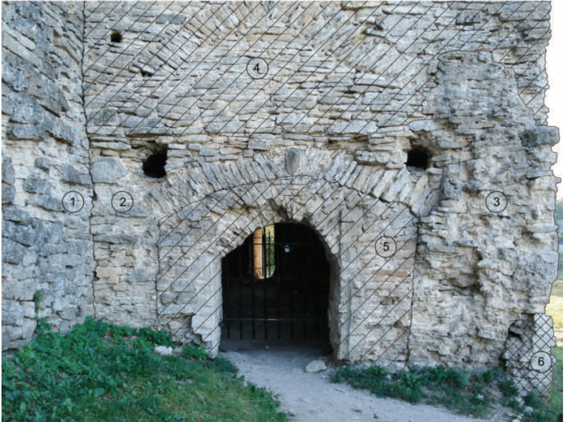
Рис. 11. Талавские захабные ворота, вид с востока. Первый строительный этап: 1 — северная стена крепости; 2 — западная стена захаб с воротами; 3 — фрагмент северной стены захаб. Второй строительный этап: 4 — восточная стена башни Талавской; 5 — закладка ворот захаб и устройство ворот башни; 6 — кладка 1845 г.
