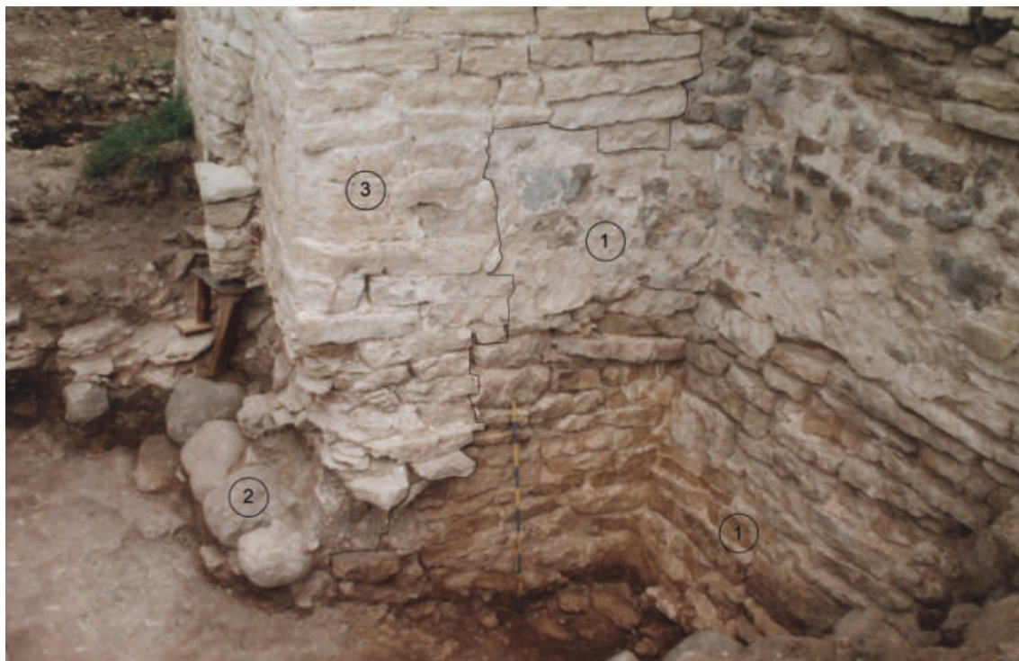
Рис. 8. Северная стена и северный откос Талавских ворот, вид с востока. 1 — кладка первого строительного этапа; 2 — фрагмент кладки последующей реконструкции ворот; 3 — откос ворот после последней реконструкции
