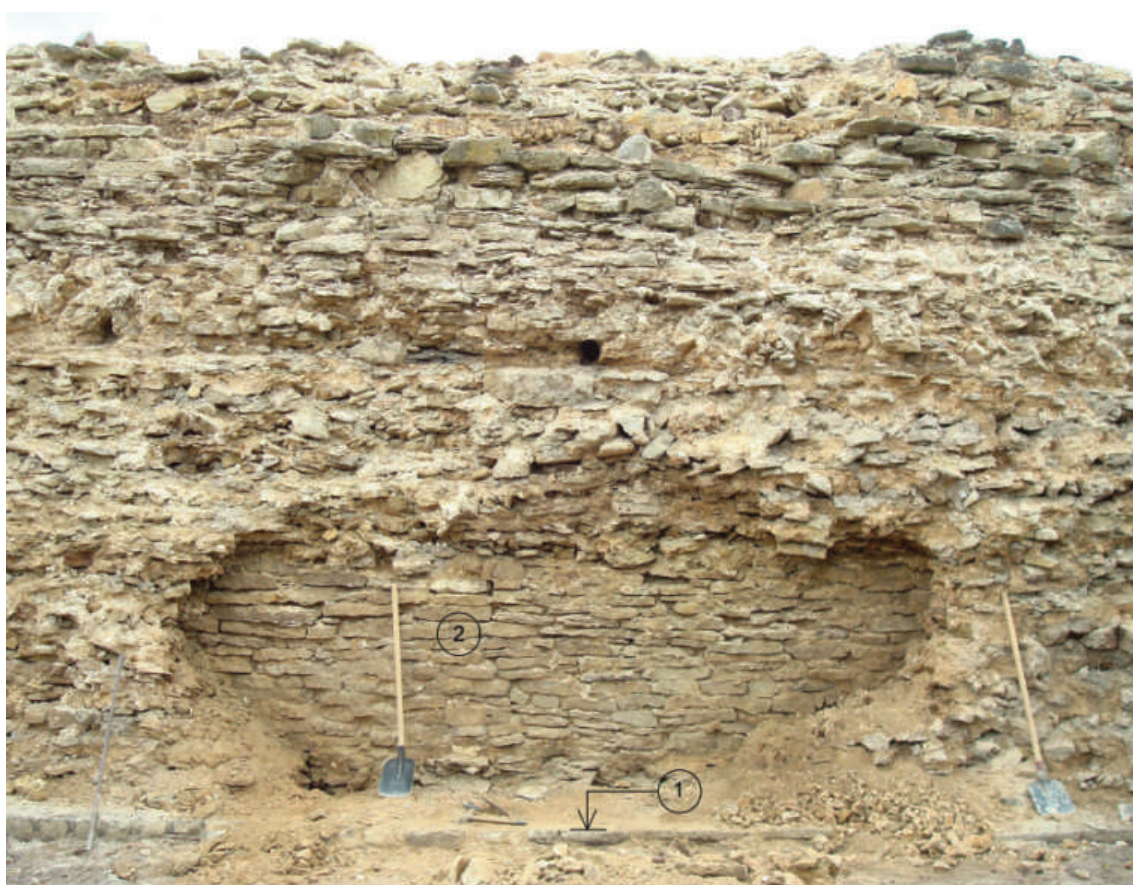
Рис. 6. Северная стена во время реставрационных работ 2011 г. 1 — уровень ходовой площадки первого строительного этапа; 2 — бруствер первоначальной стены
