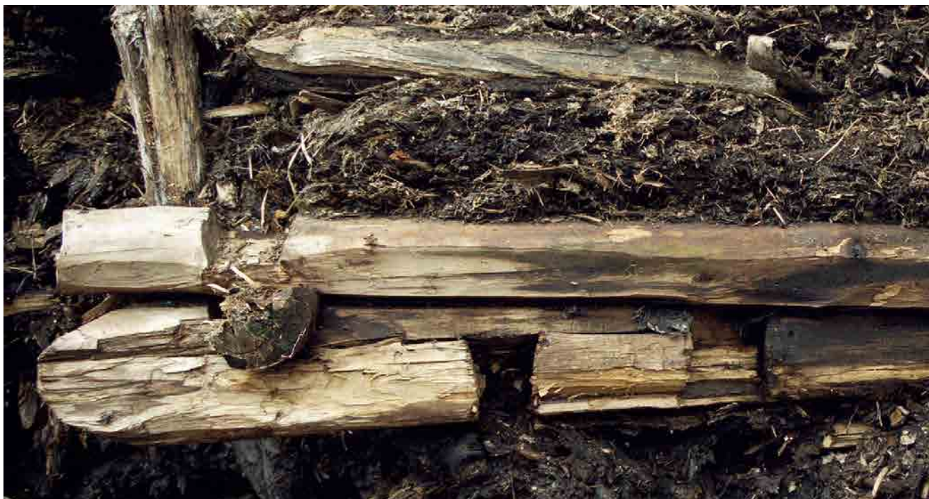
Рис. 25. Постройка 21. Восточный угол. Пазы врубки для лаги. Фото О. В. Кардаша, 1999 г.
