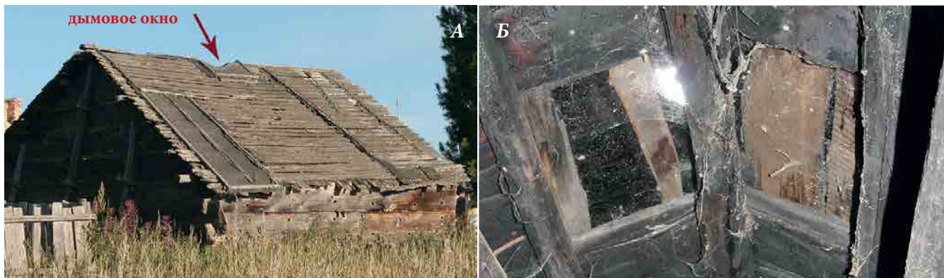
Рис. 14. Священный дом Тырлина в поселке Хошгорт. А) В верхней части кровли небольшое отверстие для дымоудаления (дымовое окно). Б) Вид отверстия для дымоудаления внутри постройки
