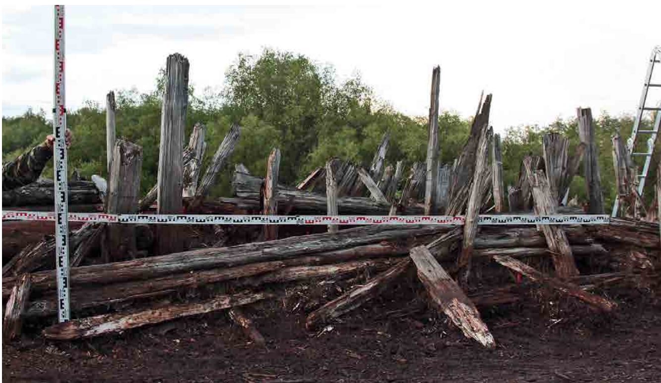
Рис. 5. Фрагмент наружной стены оборонительно-жилого комплекса. Несъемная опалубка, сформированная из горизонтального набора бревен (плах), удерживаемых вертикальными опорами
