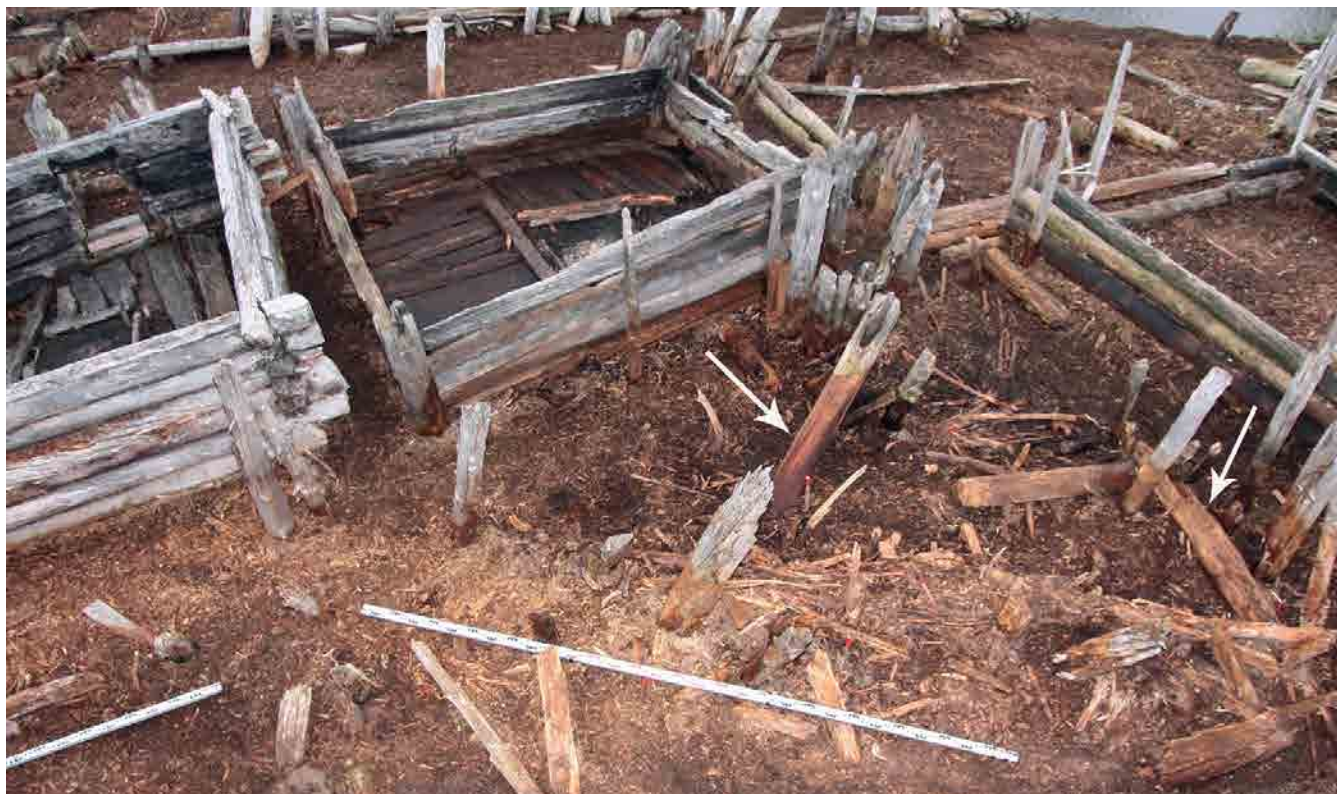
Рис. 6. Обойма, соединяющая между собой две противоположные стороны опалубки
