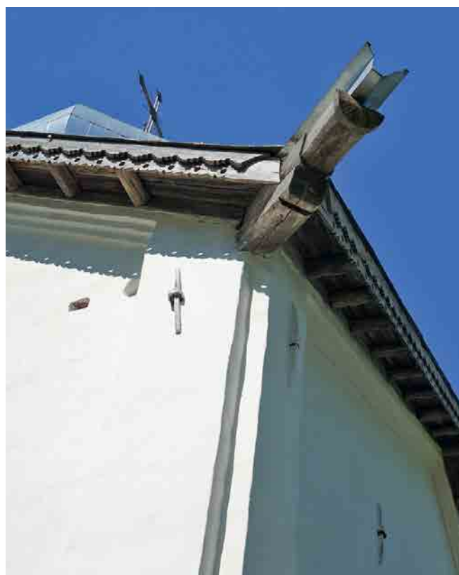
Рис. 7. Великий Новгород. Троицкая церковь XIV в. Элемент конструкции кровли
