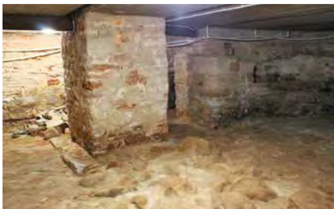
Рис. 7. Церковь Троицы в Ямской слободе Новгорода Великого. Подцерковье. Интерьер храма, реставрация на период с 1365 года. Основание колонн. Фото В. В. Гаевской 2019 г.
