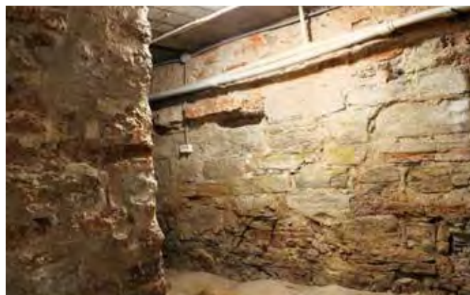
Рис. 8. Церковь Троицы в Ямской слободе Новгорода Великого. Подцерковье. Интерьер храма, реставрация на период с 1365 года. Кладка основания стен. Фото В. В. Гаевской 2019 г.
