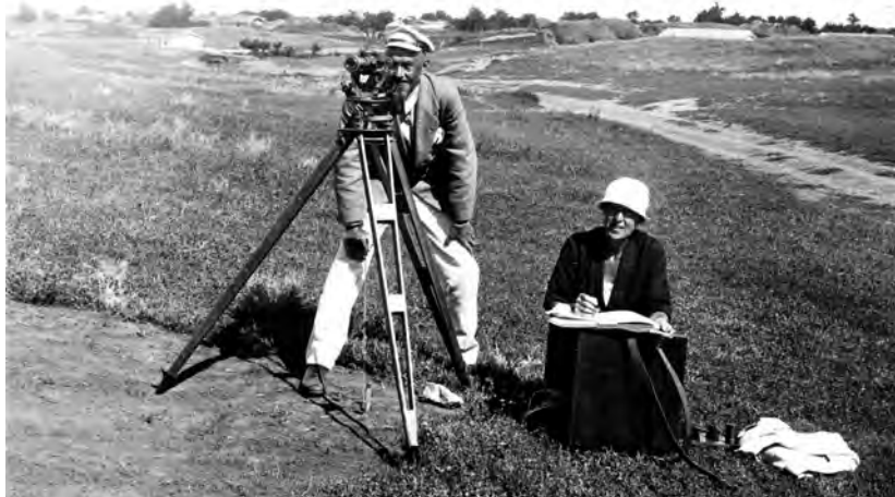
Н.Б. Бакланов и Т.М. Девель производят тахеометрическую съемку в Ольвии. 1926 г.
