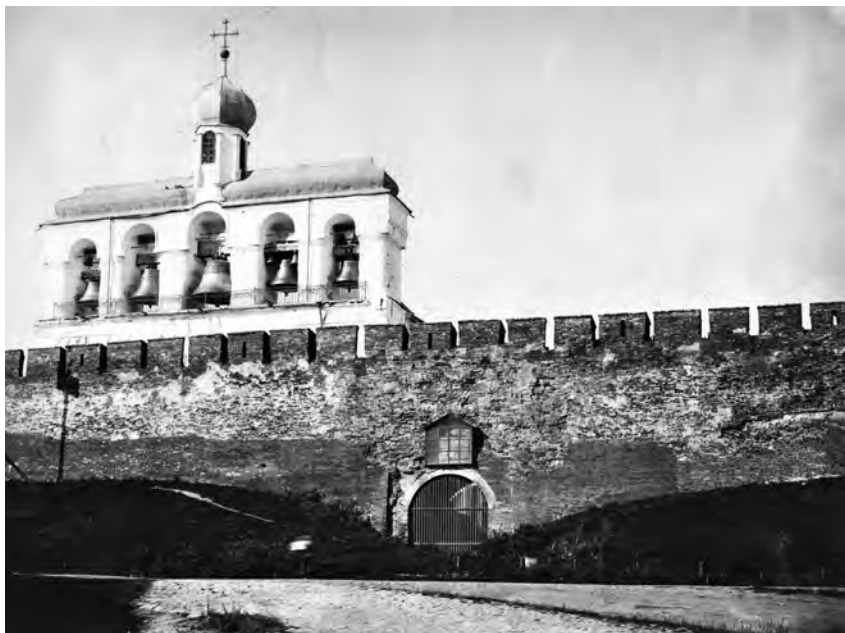
Новгород. Стены Кремля. Прясло с водяными воротами. Материалы обследования П.П. Покрышкина в 1910 г. Фото И.Ф.Чистякова
