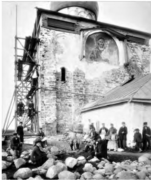
Церковь Спаса на Нередице. Реставрационные работы летом 1903 г. Сн. И.Ф. Чистякова
