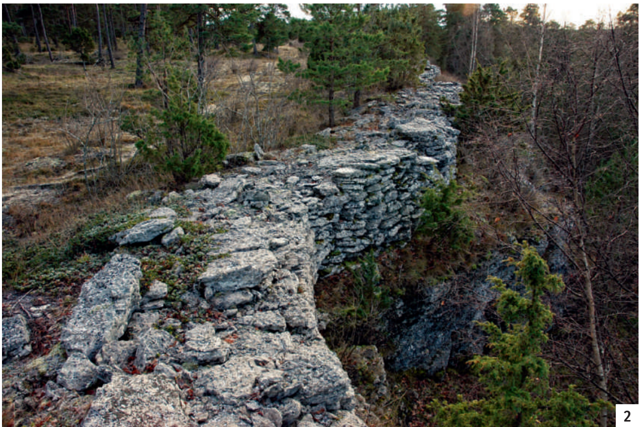
Рис. 440. Торшбурген, Готланд. Фортификационные сооружения. Фото И. И. Еремеева
