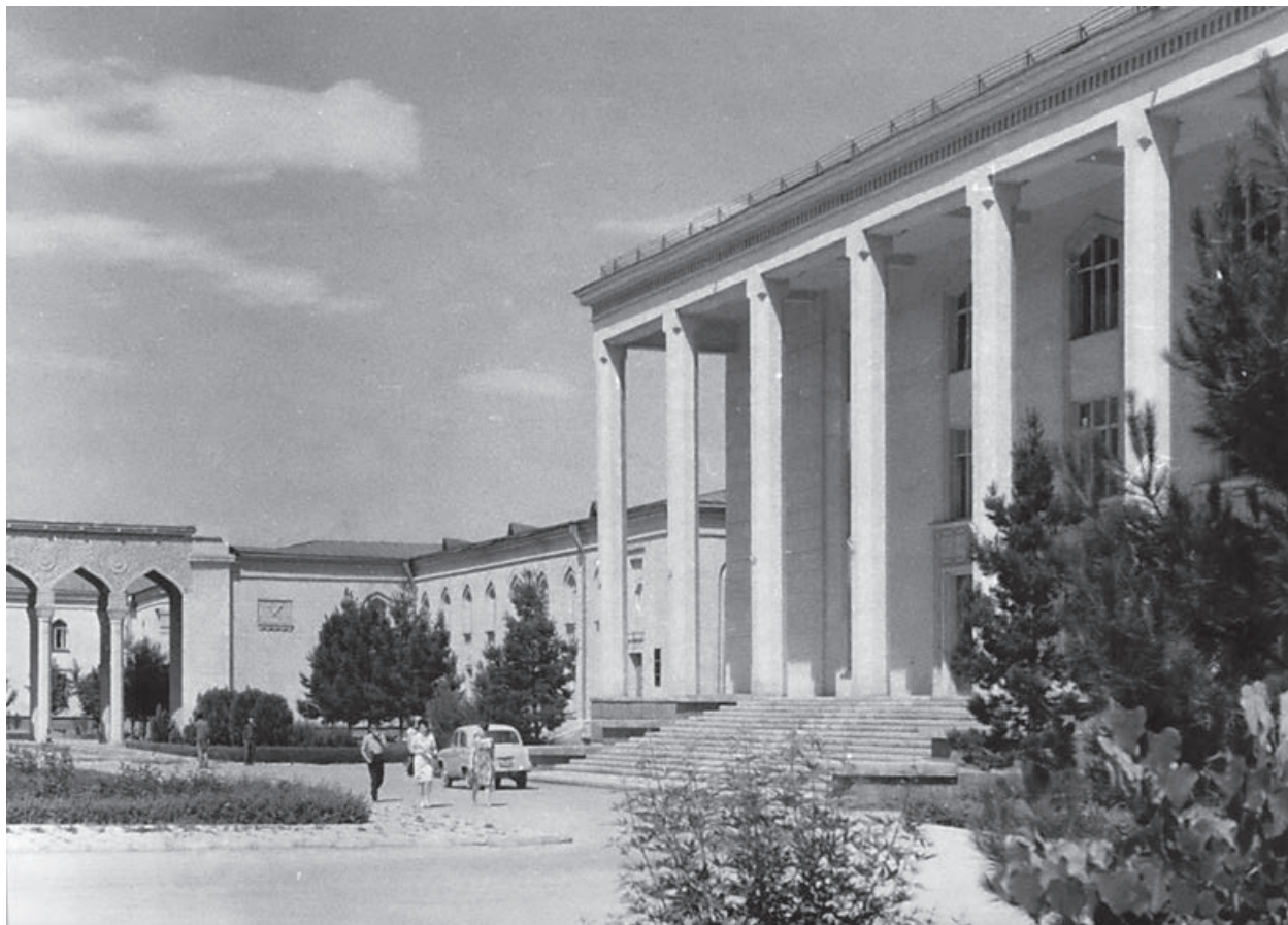
Здание Института истории им. Ш. Батырова (в центре снимка), где В.Н. Пилипко работал с 1965 до 1994 года. Справа – здание Президиума Академии наук Туркменской ССР. Из архива Р.Г. Мурадова
