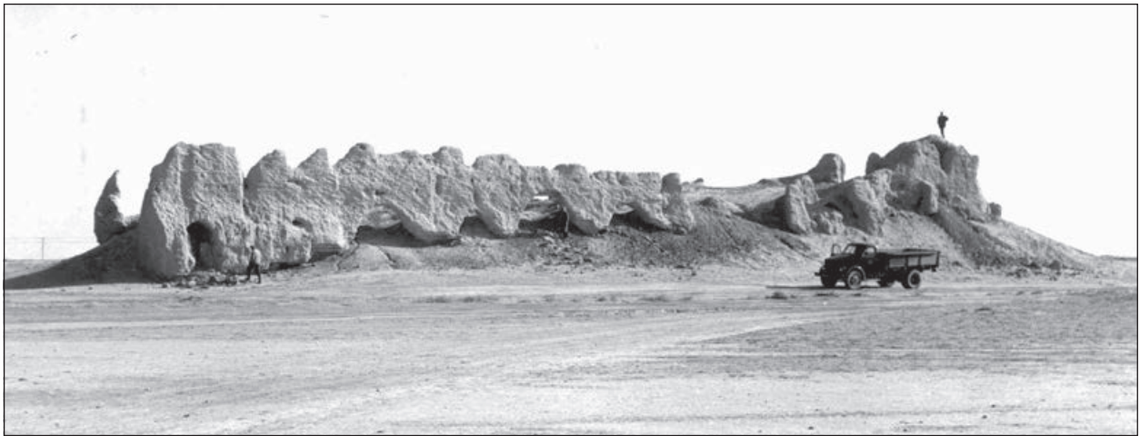
Рис. 6. Хараба-кёшк. Южный фасад, 1966 г. Архив ЮТАКЭ
