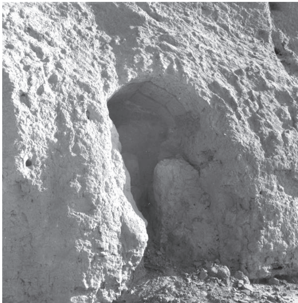
Рис. 14. Хараба-кёшк. Сводчатый проем на южном фасаде. 1966 г. Архив ЮТАКЭ
