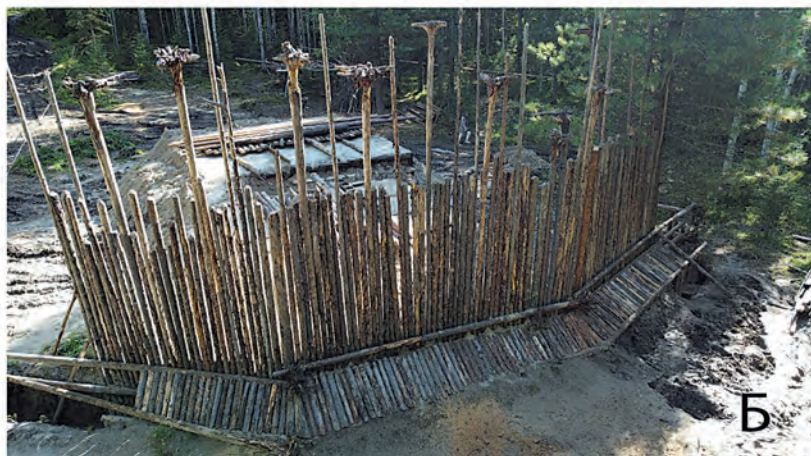
Рис. 1. Реконструкция жилого-оборонительного сооружения Каюково 2: А – 3D-модель поселения, выполненная Д. А. Плехановым; Б – стройплощадка, лето 2023 г.
