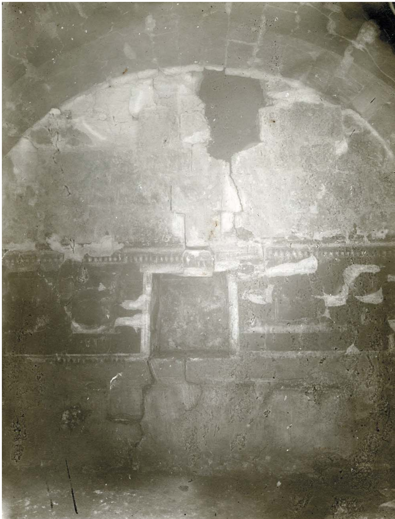
Ил. 92. Таманский полуостров. Васюринская гора. Склеп № 1. Вид западной стены главной комнаты. Фото М. С. Рубанчика, 1907 г. ФО НА ИИМК РАН, отп. Q 304/3
