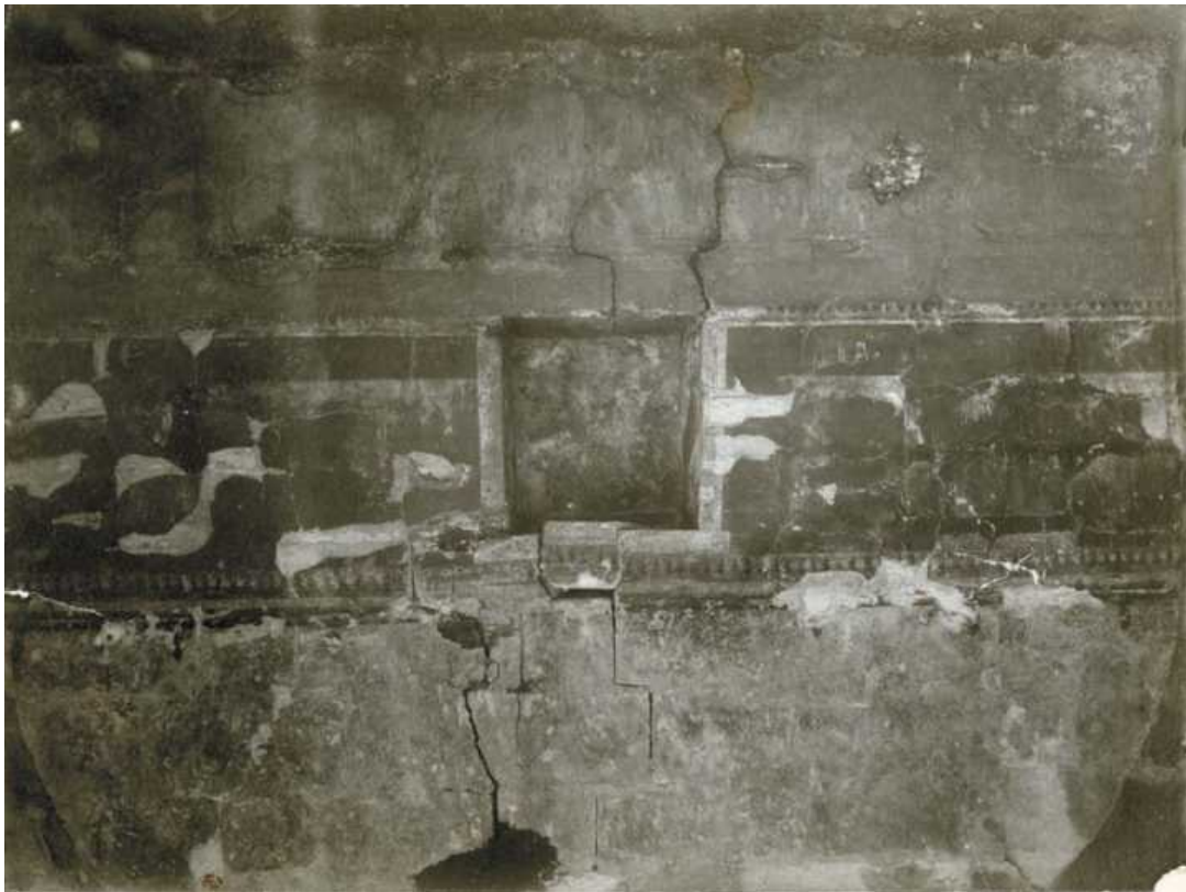
Ил. 93. Таманский полуостров. Васюринская гора. Склеп № 1. Вид западной стены главной комнаты. Фото М. С. Рубанчика, 1907 г. ФО НА ИИМК РАН, отп. Q 304/4
