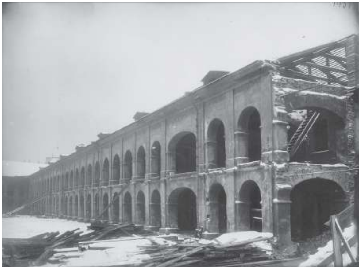
Петербург. Процесс разборки Гостиного двора на Васильевском острове. Фото И. Ф. Чистякова 1912–1913 гг. (ФА, О.445/718)
