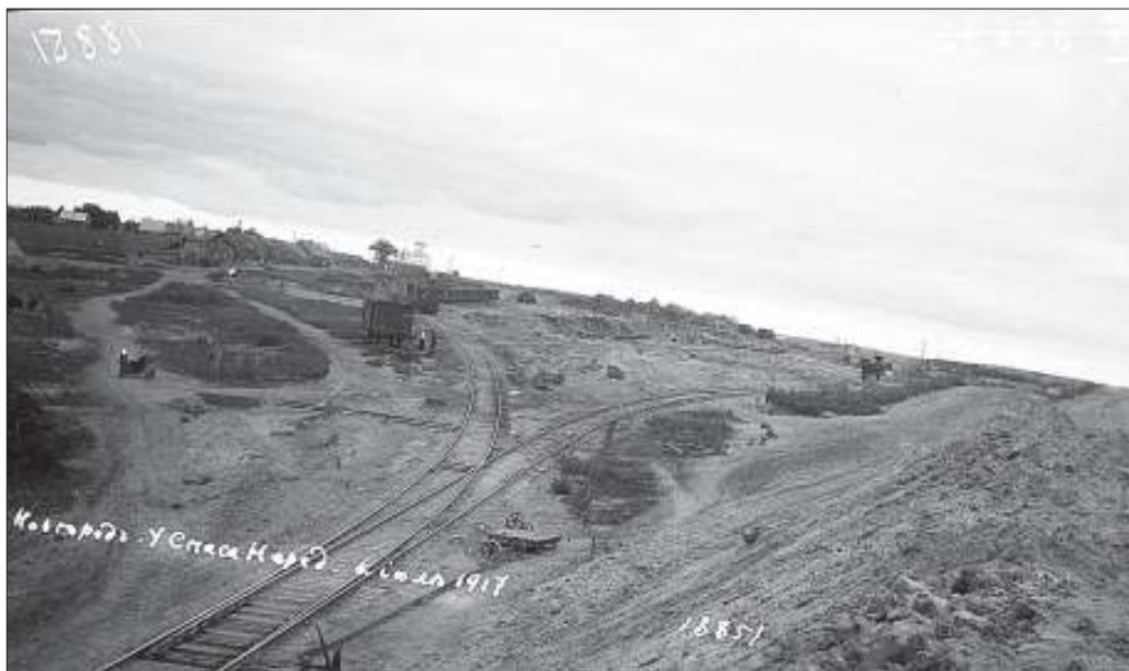
Новгород. Строительство железной дороги у Спаса-Нередицы. Фото П. П. Покрышкина, июль 1917 г. (ФА, II 34035)
