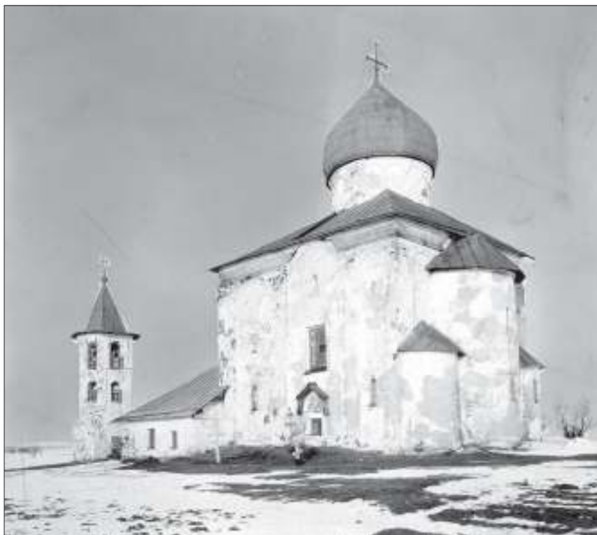
Церковь Спаса на Нередице под Новгородом до реставрации. Вид с юго-востока (ФА, О.623/2)
