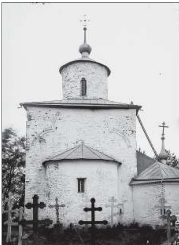
Церковь Успения на Волотове под Новгородом. Общий вид. Работы В. В. Сулова 1894–1895 гг. (ФА, II 14184)
