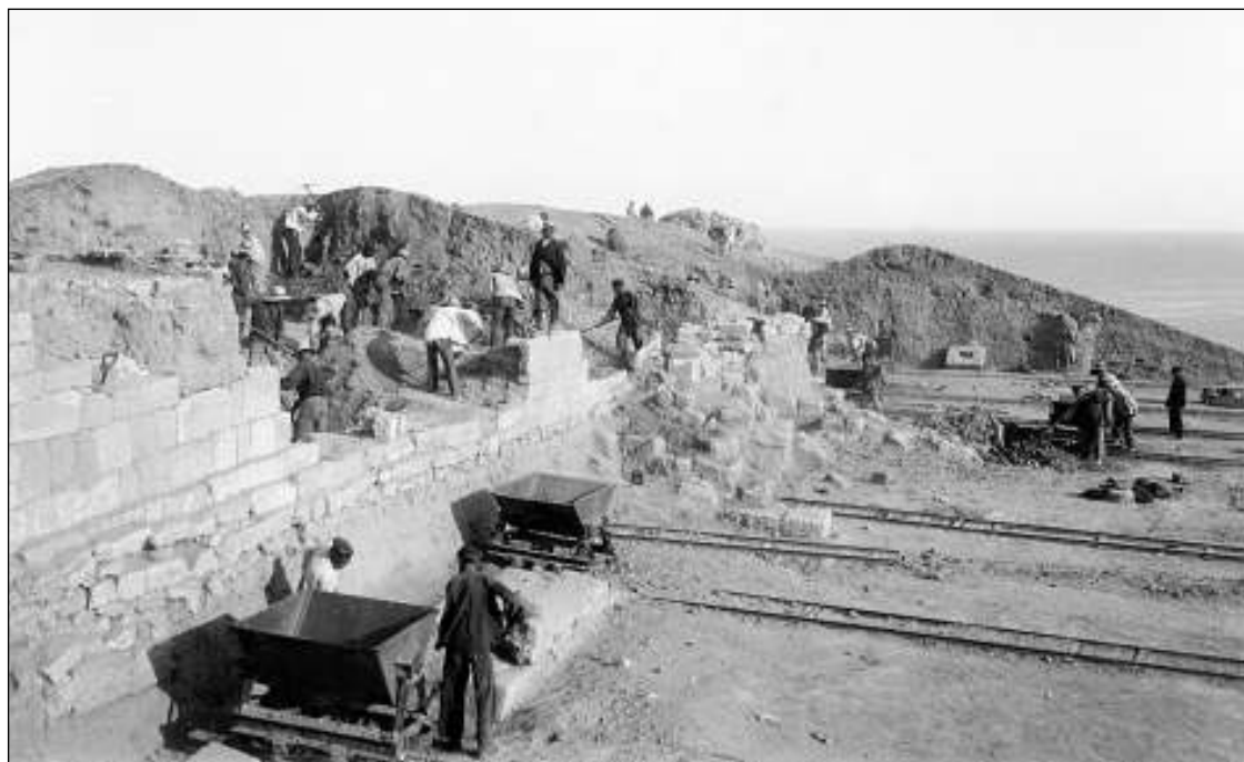
Ольвия. Общий вид на южную часть городской стены. Раскопки Б. В. Фармаковского 1904 г.
