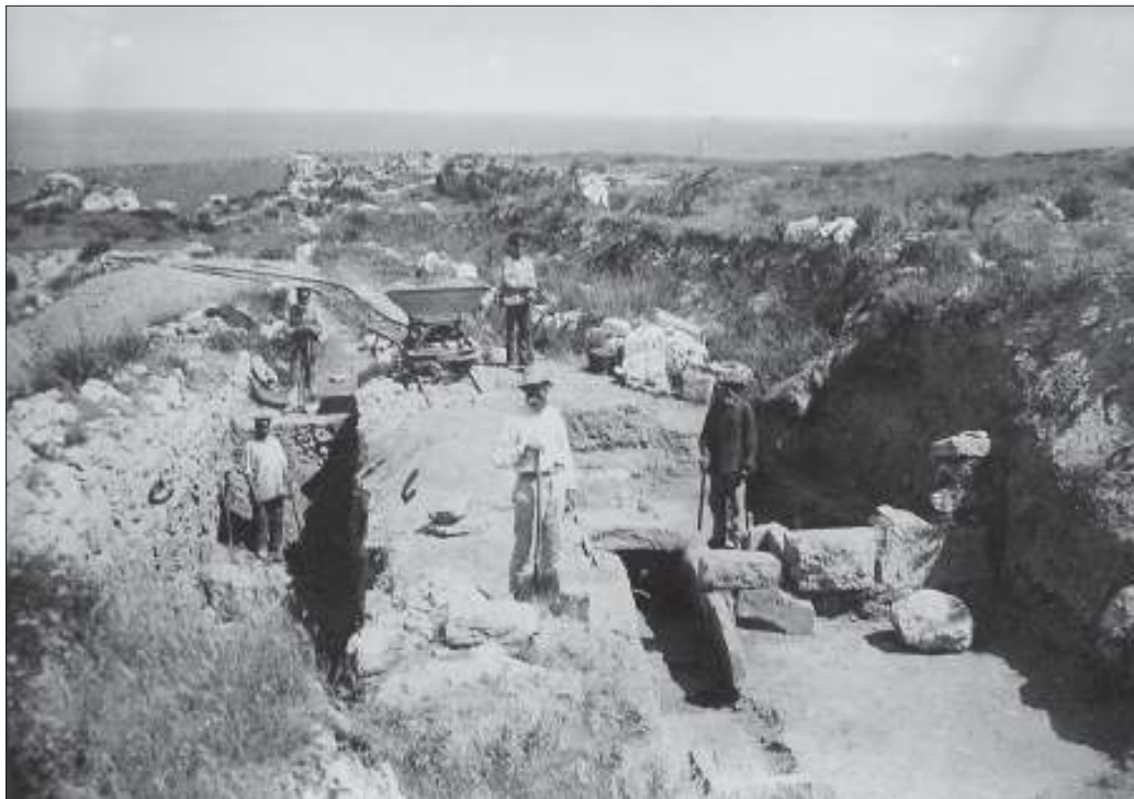
Раскопки участка оборонительной стены в западной части Херсонеса (Моисеев 1919: рис. 93)
