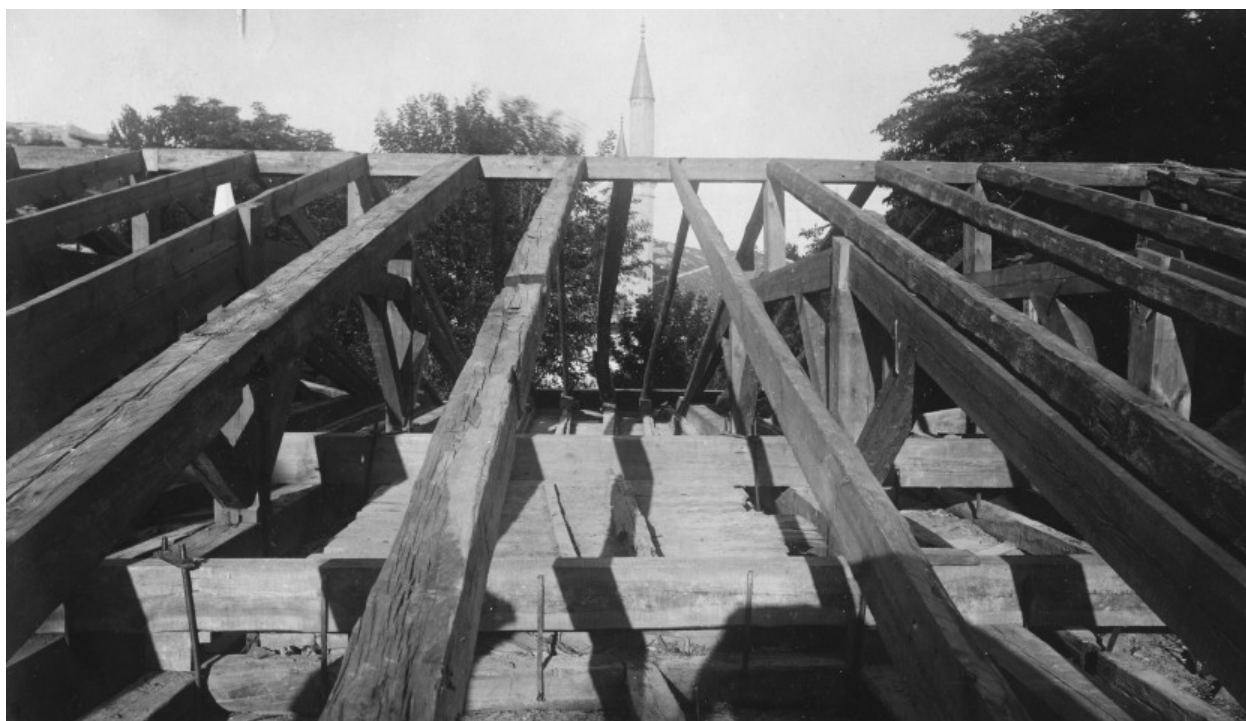
Рис. 9. Дворец, Бахчисарай, Крым. Перекрытия Екатерининского зала. Фотография С. С. Некрасова. 1915 г. ФО НА ИИМК РАН. Отп. О. 411-2177
