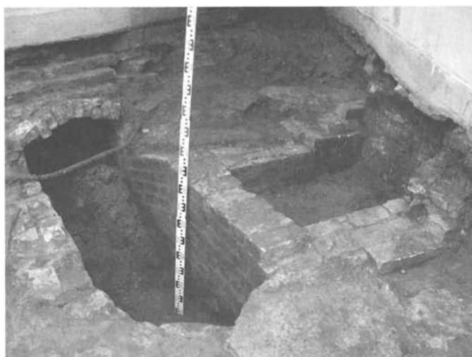
Рис. 11. Петропавловская крепость. Объект 4 (Никольская куртина). Остатки фундамента трубы и дымохода Монетного двора, вид с севера
