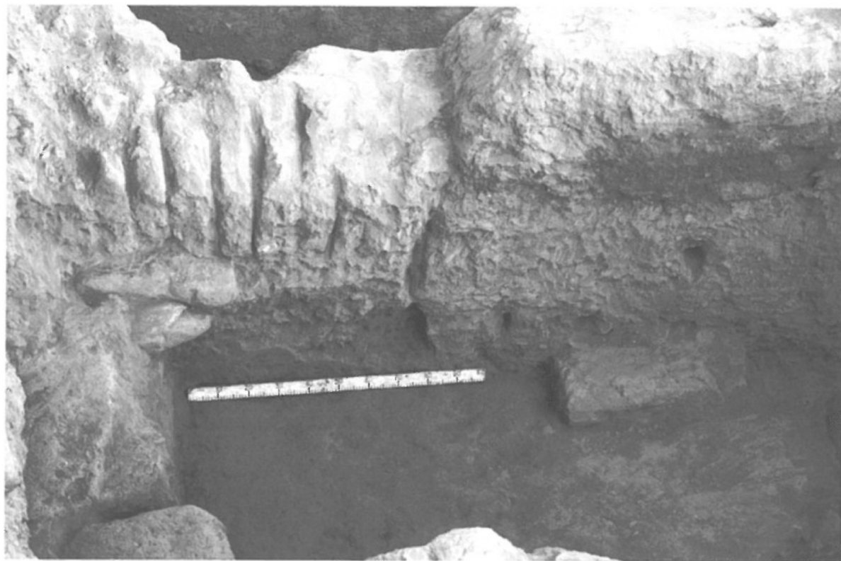
IV. Объект X, помещение 24. Метровая рейка лежит около заложеного прохода в помещение 22. Видна штукатурка поверх закладки прохода
