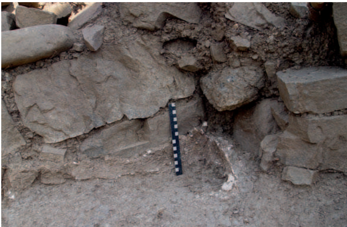
Рис. 1.30. Остатки известковой штукатурки на северном заплечике наоса. Кладки апсиды первого и третьего строительных периодов. Вид с юго-востока. Fig. 1.30. Remains of mortar on the northern part of the naos, wall masonry of the apse in the first and third building periods, view from southeast.
