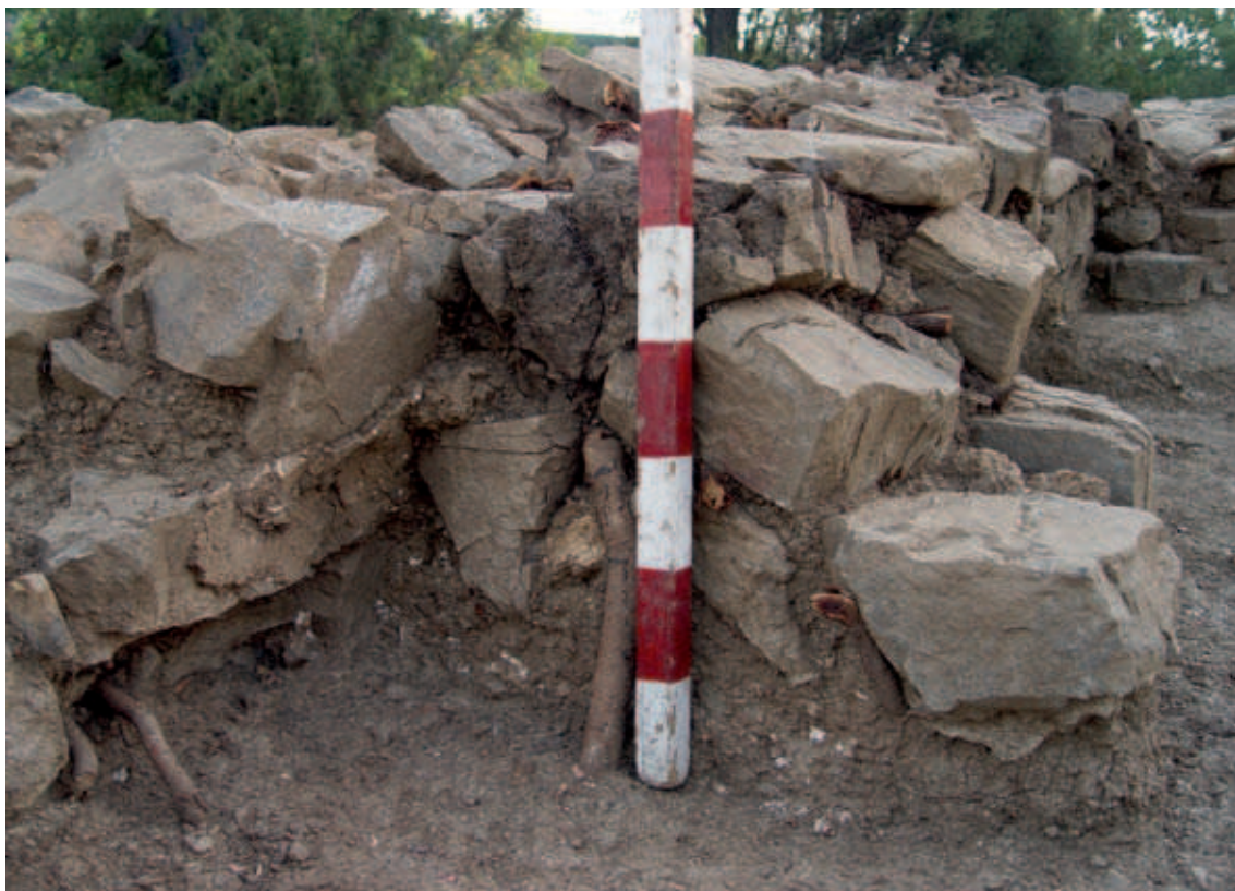
Рис. 1.52. Кладка северо-западной части перегородки южного компартамента. Вид с юга. Fig. 1.52. Wall masonry of the northwestern part of the partition in the southern part of the church, view from south.
