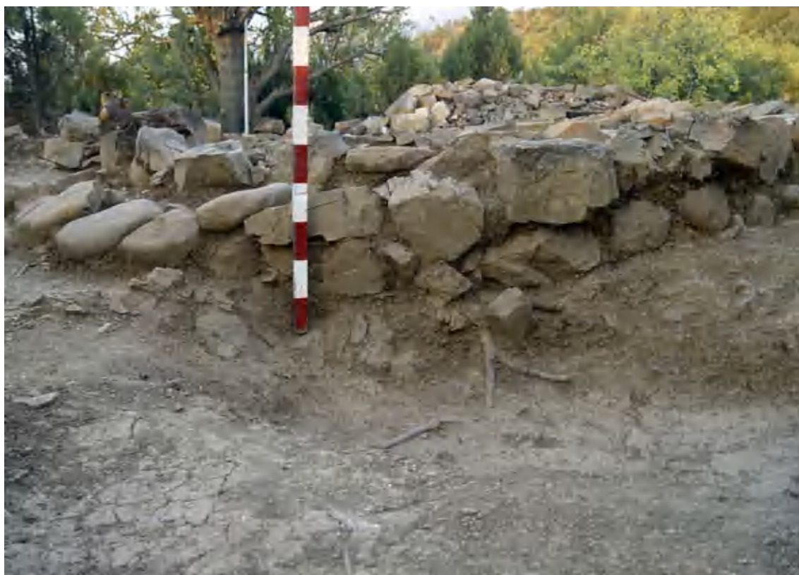
Рис. 1.6. Южная апсида. Фрагмент. Кладка первого строительного периода. Вид с северо-востока. Fig. 1.6. Southern apse, wall masonry of the first building period, view from northeast.
