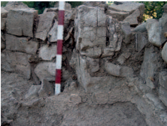
Рис. 1.12. Южная апсида. Фрагмент. Южное заплечико первого строительного периода с остатками известковой штукатурки и облицовка апсиды третьего строительного периода. Вид с юго-запада.
