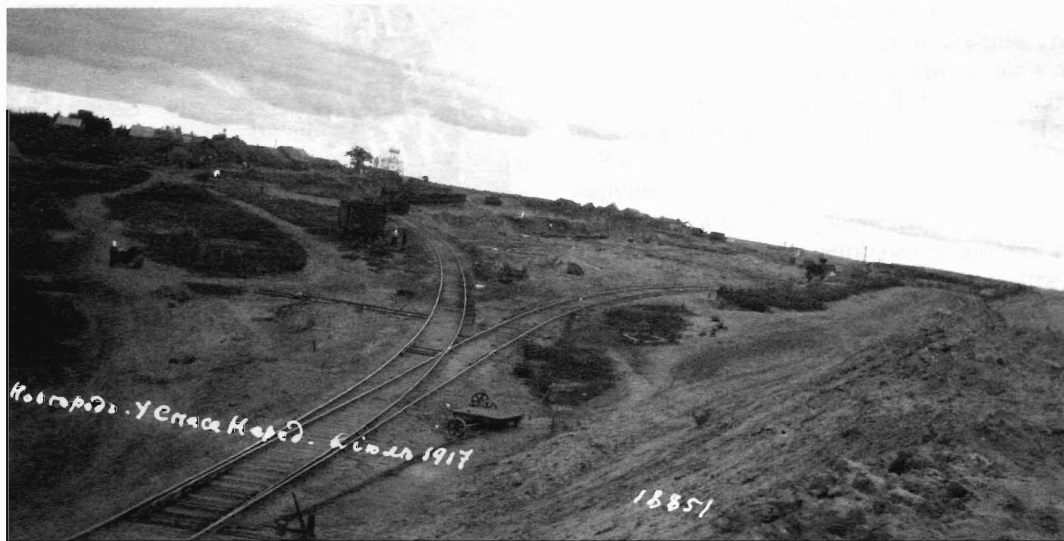
Рис. 8. Вид на строящуюся железнодорожную насыпь у церкви Спаса на Нередице. Снимок П. П. Покрышкина, 1917 г.
