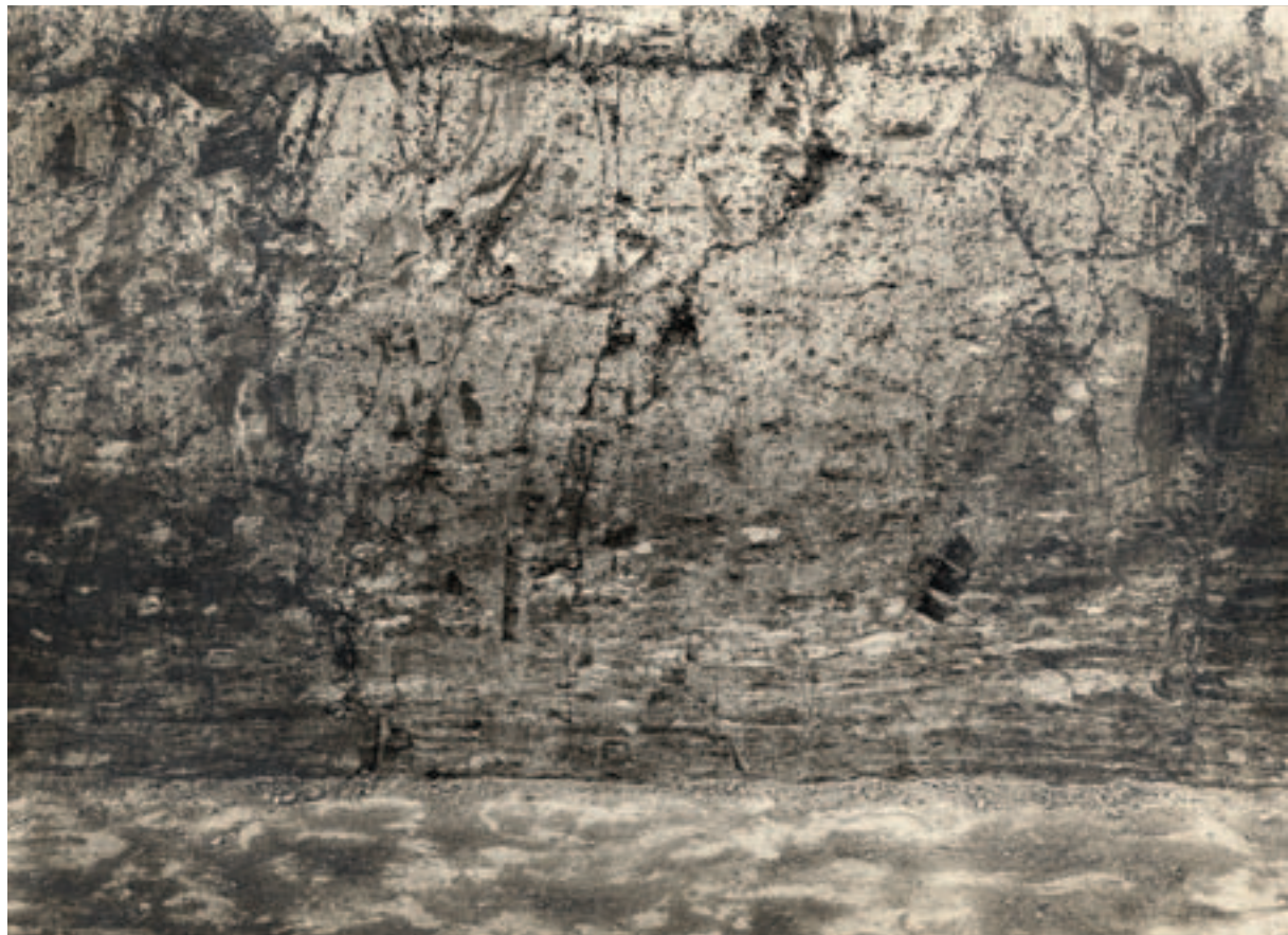
Табл. 73. ДЕТАЛЬ НАСЫПИ (СТЕНКИ №4). Фото В. В. Саханёва, 1914 г. ФО НА ИИМК РАН, отп. Q 600/3
