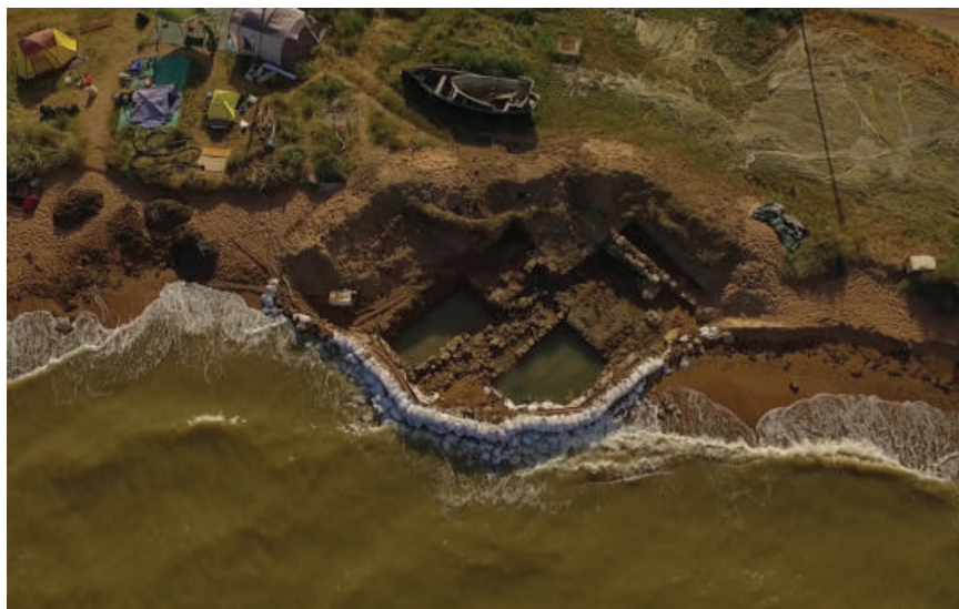
Рис. 144. Обустройство отсечной дамбы при исследованиях участка «Береговой». Акра, 2016 г.
