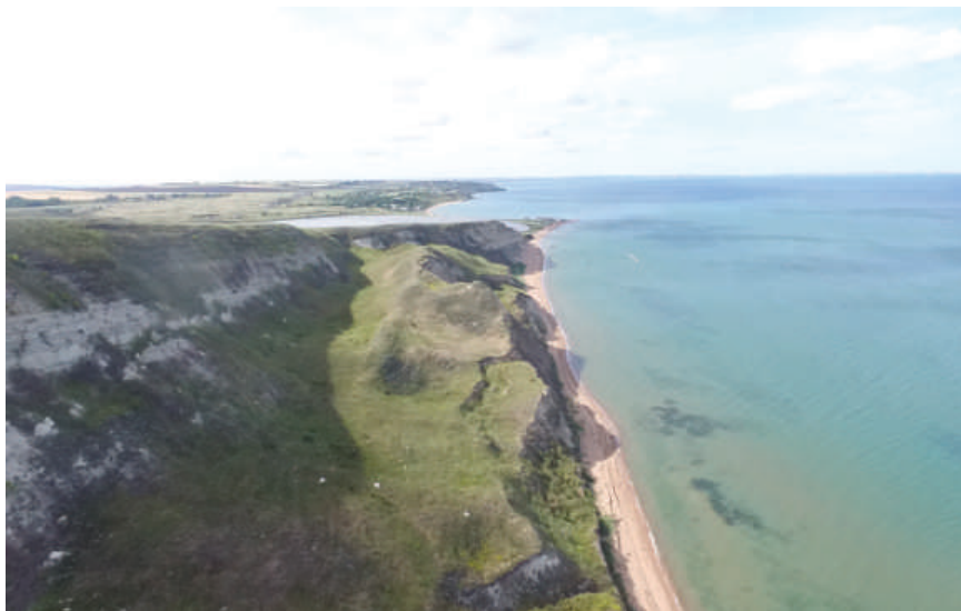
Рис. 2. Оползневый участок морского побережья к югу от Акры. Вид с юга
