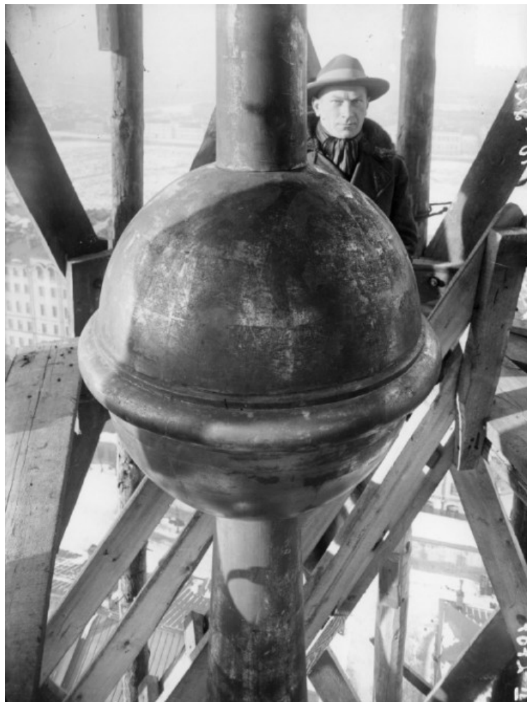
Рис. 2. Ленинград, реставрация Адмиралтейства, яблоко шпиля. На лесах — Н. М. Бачинский, фото 1927 г. (НА ИИМК РАН. ФО. Отп. О.3565-122)
