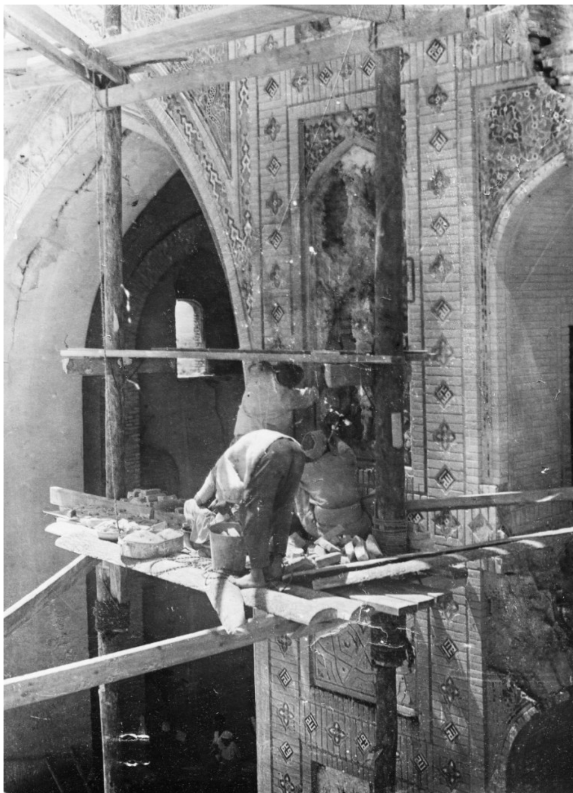
Рис. 6. Анау, мечеть XV в., укрепление облицовки ложной арки на правой стороне портала, фото 1936 г. (НА ИИМК РАН. ФО. Отп. О.1228-49)
