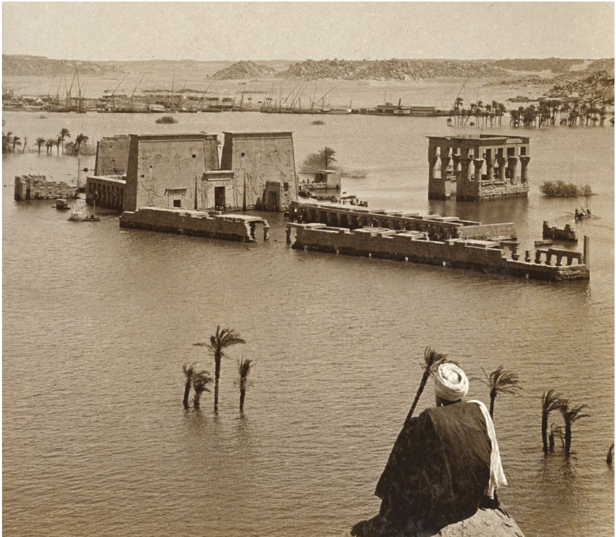
19. Вид храмов Филэ, затопленных после возведения первой Асуанской плотины. Фото: С. Х. Грейвс, ок. 1904
