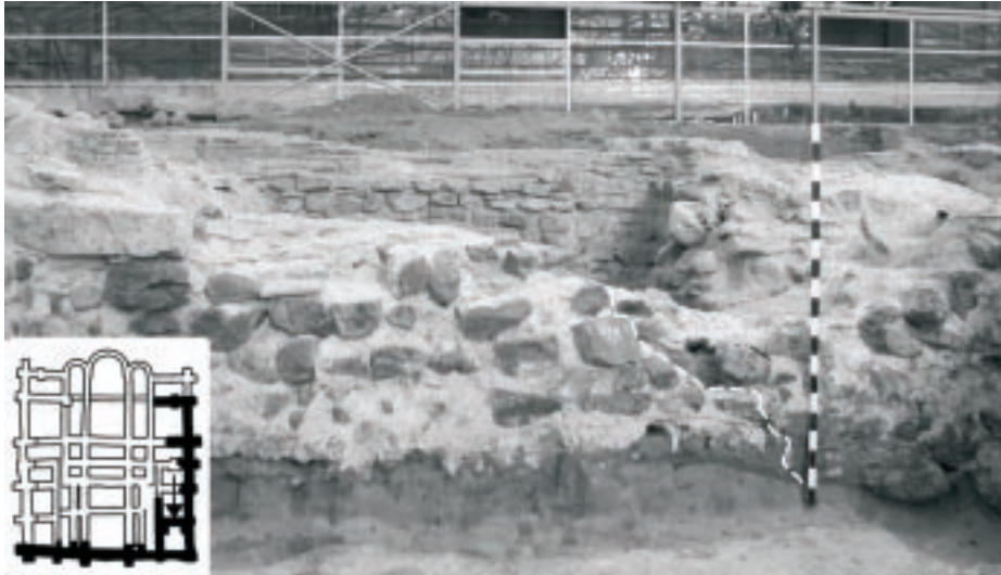
Рис. 6. Фундамент первой с запада перемычки южной галереи, вид с северо-востока. Пунктиром показана граница стыка «кварцитовой» (слева) и «песчаниковой» (справа) частей
